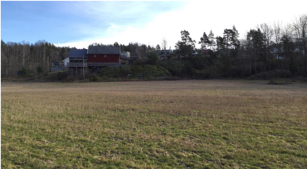
Figur 10. Bilde tatt ved elvebredden i retning sør. Nordre Labu gård (i bilde) er fundamentert på berg i dagen.
