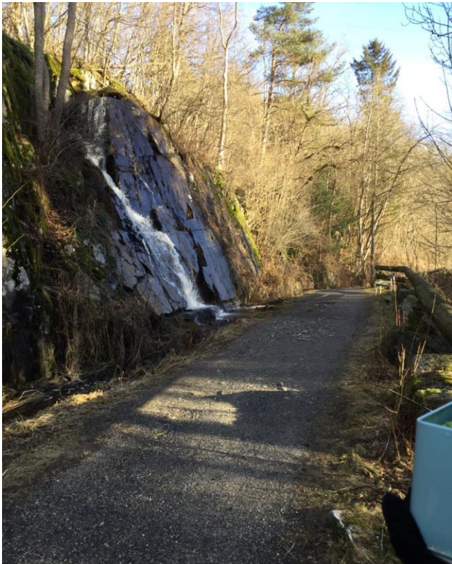
Figur 2. Tatt i retning øst langs bilvei. Vannet renner langs bergsiden og føres under veien i rør. Vannet renner videre ned i en ravine.
