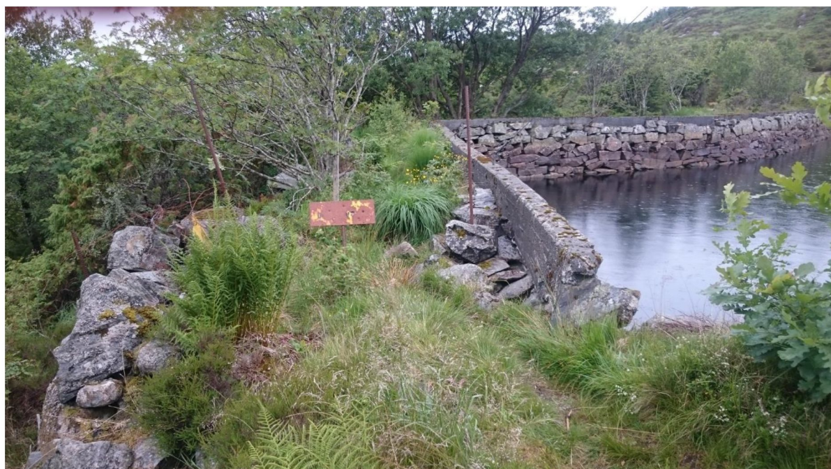
Bilde 8 Bilde av dam sett fra oppstrøms side. Bildet er tatt mot vest.
