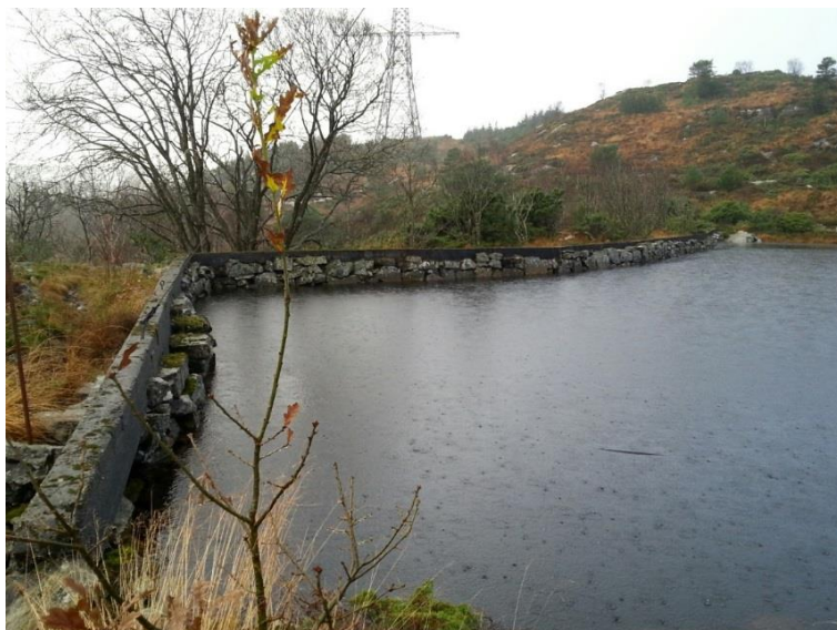
Bilde 1 Hoveddam og sidedam. Dammens oppstrøms side sett mot vest.
