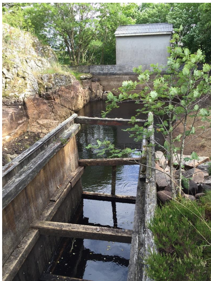
Bilde 5 Oppstrøms side av silhuset med basseng. Bildet er tatt mot sør.
