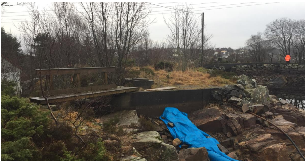
Bilde 3 Overløpsterskel i terreng/ fast berg er under bru. På bildet er magasinet ca. 2,0 m under HRV. Fjellvars vannledning som går gjennom magasinet er dekket med blå plast. Bildet er tatt mot sør.
