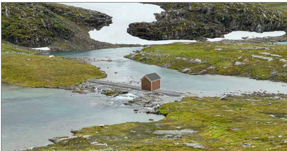
Figur 10. Plassering av ny betongterskel oppstrøms Vasshovudet medfører inngrep i noen stryk/ kulper ved utløpet fra Kjerringvatnet.
