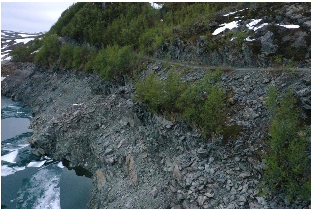
Figur 3-11: Bilde av adkomstveien til Øvre Porsa, ved Porsavatn. Terrenget er svært bratt ned mot vannet. Bilde: Hammerfest Energi
