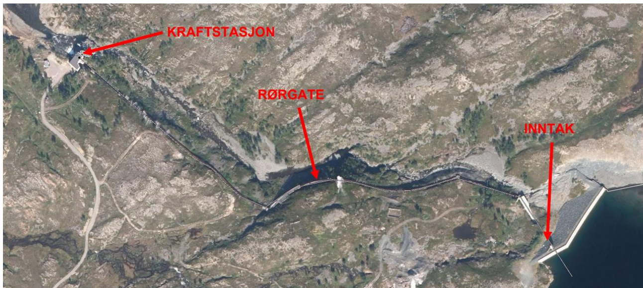
Figur 3-1. Flyfoto av kraftverket.
