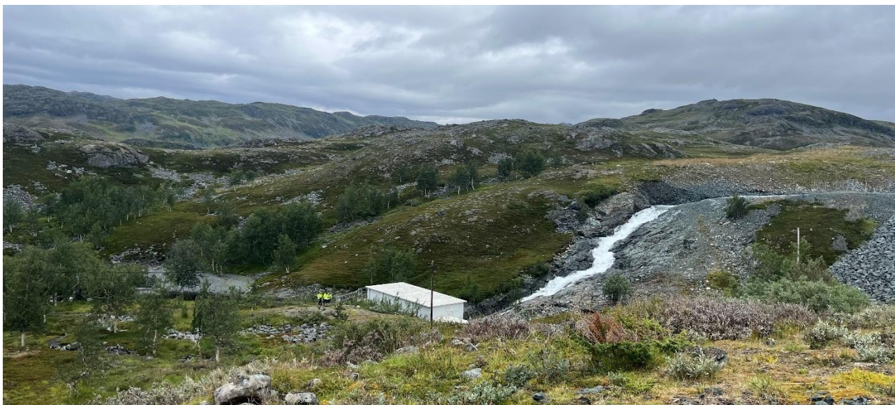
Figur 4-7 Dagens flomløp fra dam Bjørnstadvatn. Bart berg langs flomløpet/elveløpet.
