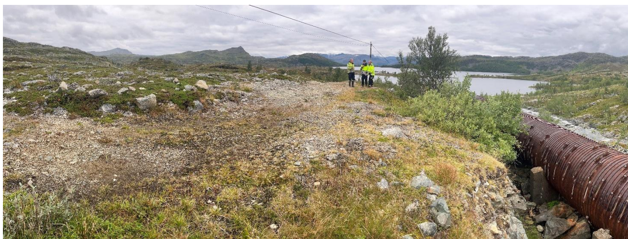
Figur 3-14. Anleggsvei langs rørgata.
