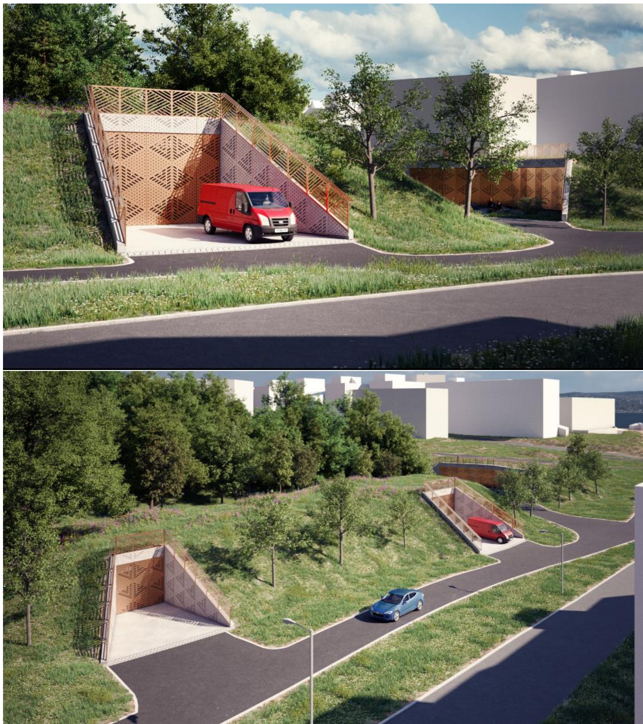
Figur 5-3. Koksa transformatorstasjon ligger nedgravd i terreng
