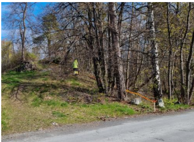
Figur 2-5 og 2-4. Markering og innmåling av anleggsgjerde. Vinkelpunktet til anleggsgjerdet er plassert i stien og langs med fjellskrenten (nedenfor, ikke oppå - se vedlegg 1) for å minimere påvirkning.
