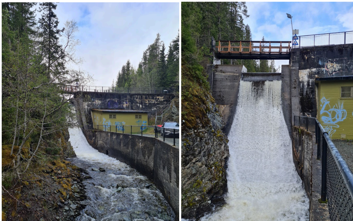
Figur 7 Dam Leirsjøen med overløp og ventilhus på luftside
