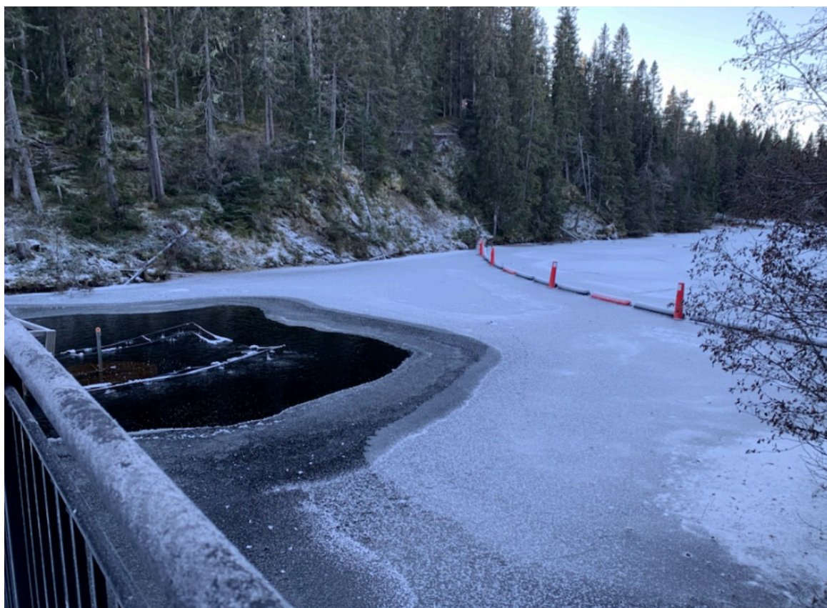
Figur 6 Barriere med vintermarkører oppstrøms Dam Leirsjøen i november 2023
