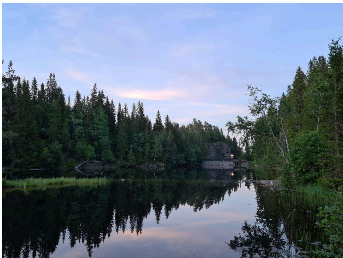
Figur 3 Dam Leirsjøen på vannside sett fra magasinet Stor-Leirsjøen
