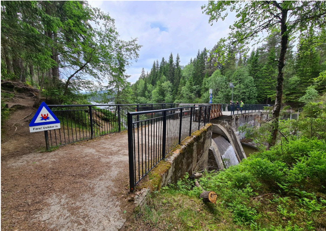
Figur 1 Dam Leirsjøen med overløp, rekkverk og skilt
