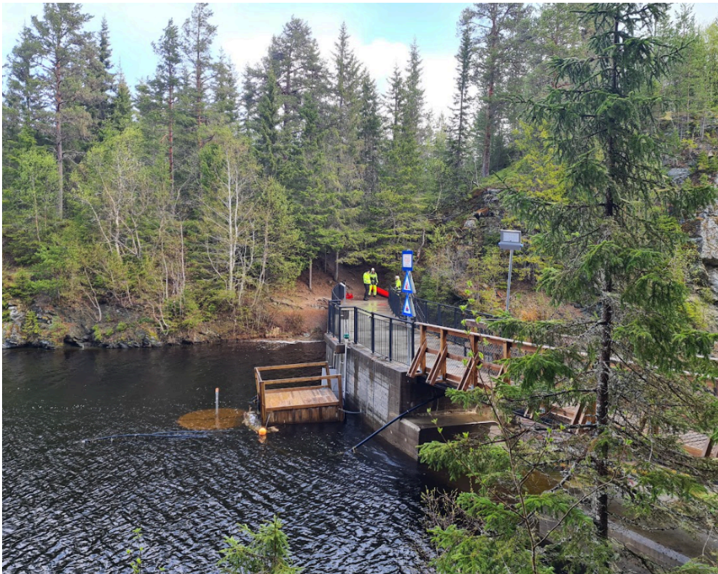
Figur 2 Dam Leirsjøen på vannside med bobleanlegg og filter over gammelt vanninntak
