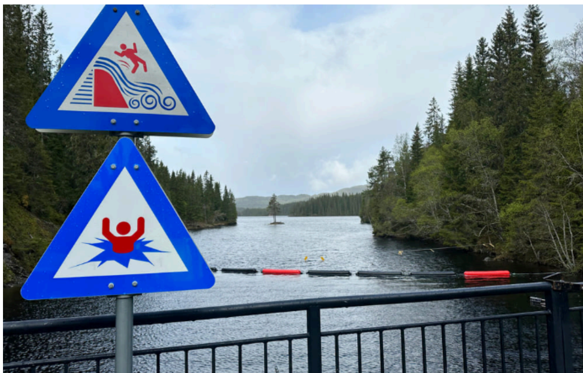
Figur 5 Barriere (uten vintermarkørene) oppstrøms Dam Leirsjøen ble montert i mai 2023
