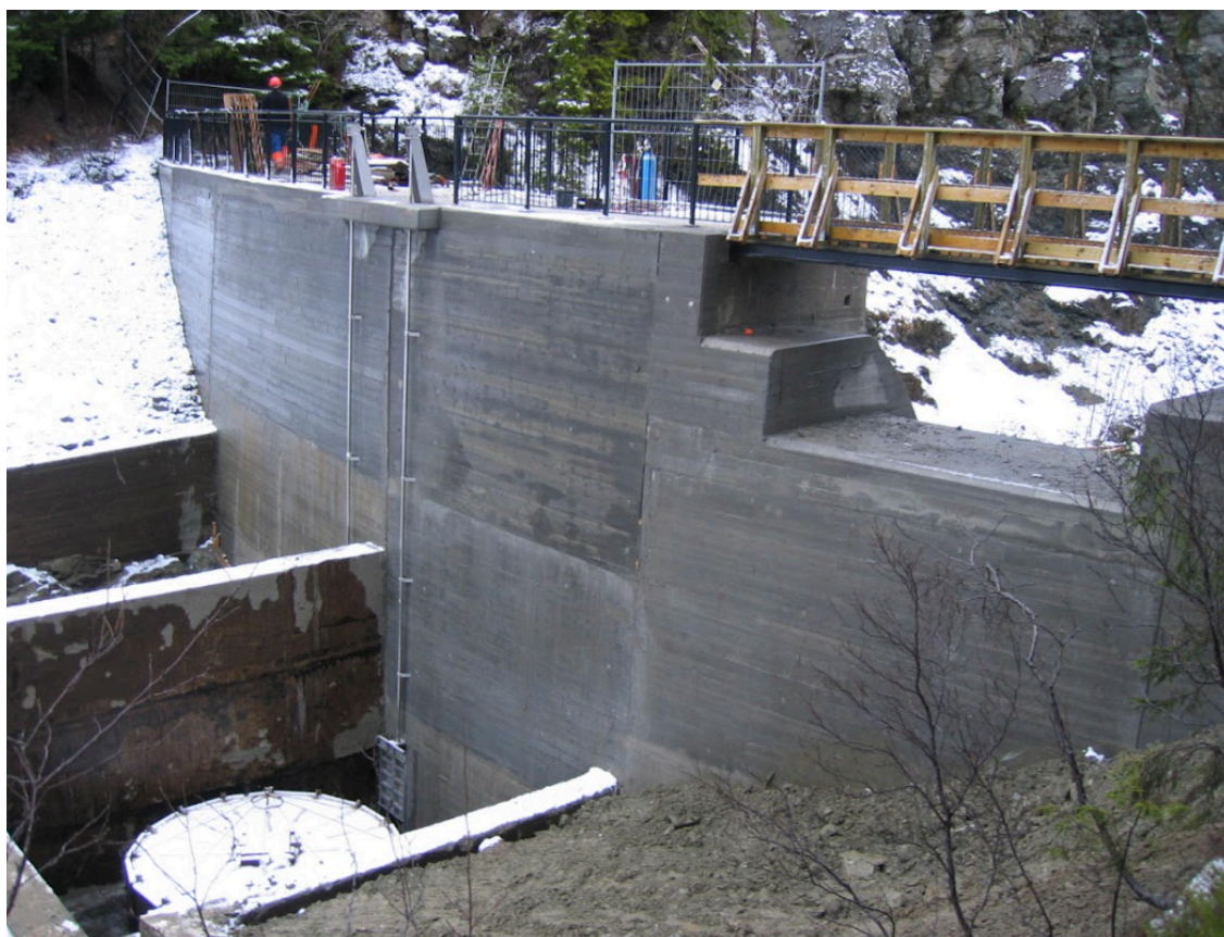
Figur 9 Rehabilitering av dam Leirsjøen i 2004
