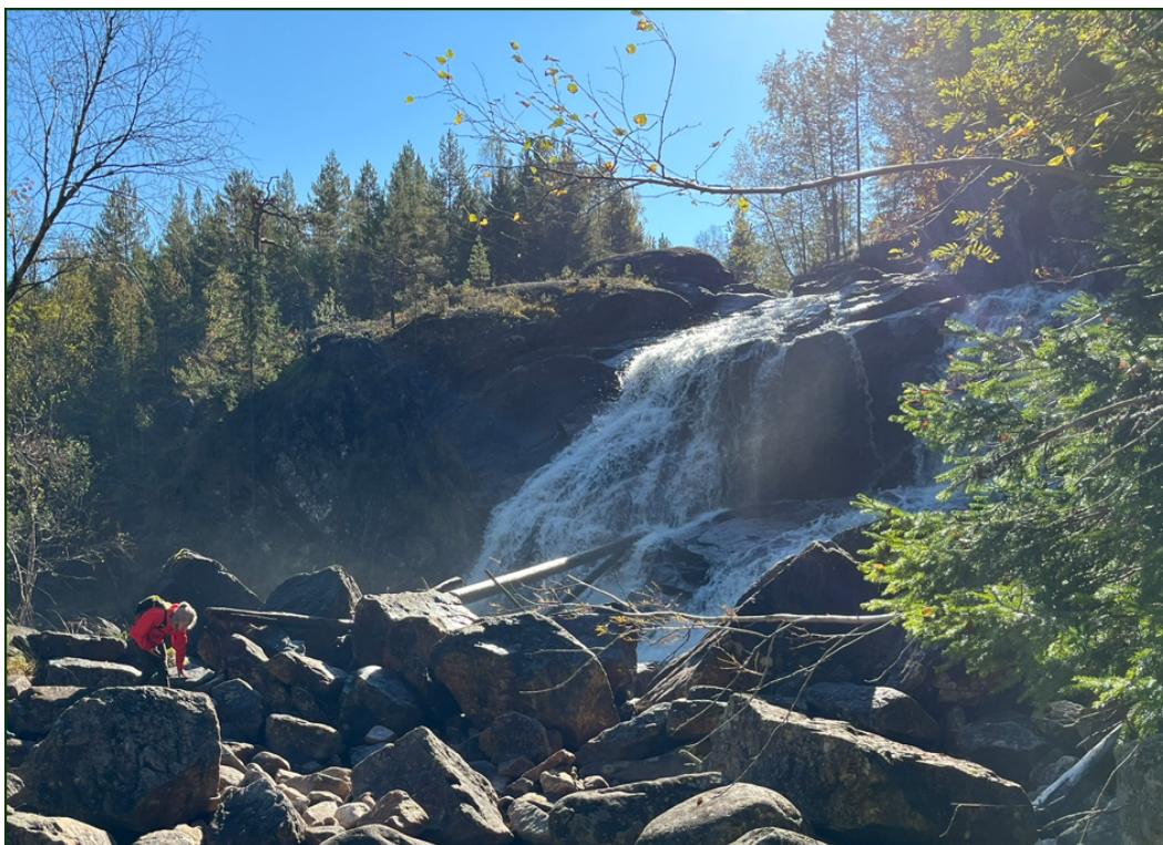
Gravefossen, rett ovenfor planlagt avløp for kraftstasjon til Gravefossen kraftverk.
