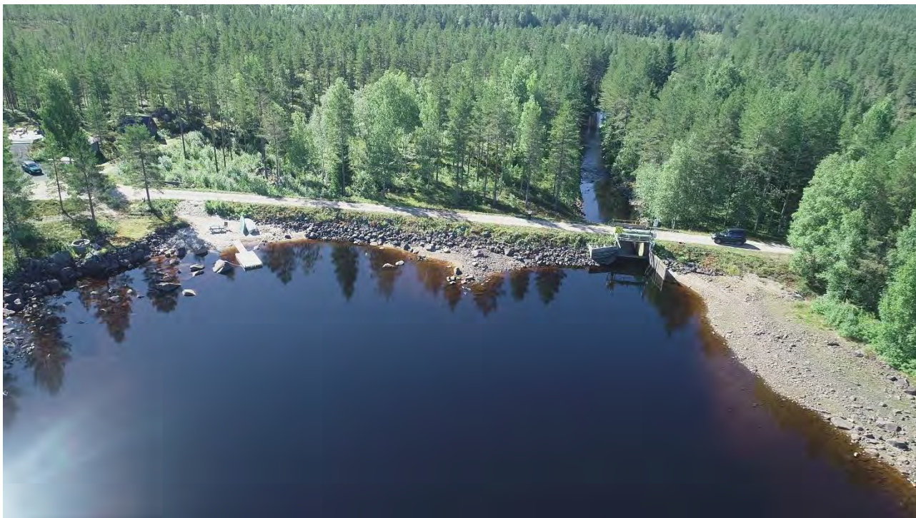
Figur 1 Røgden Nordre Hoveddam sett fra magasinsiden.
