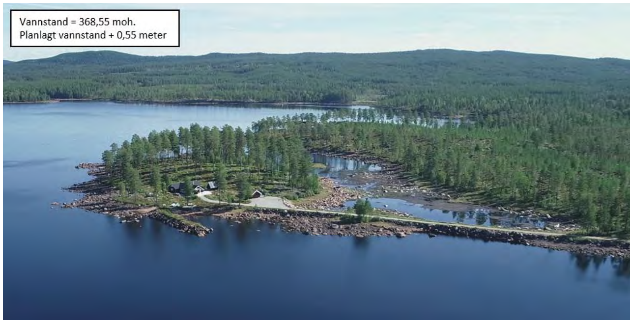
Figur 14 Nordre Røgden med redusert vannstand.
