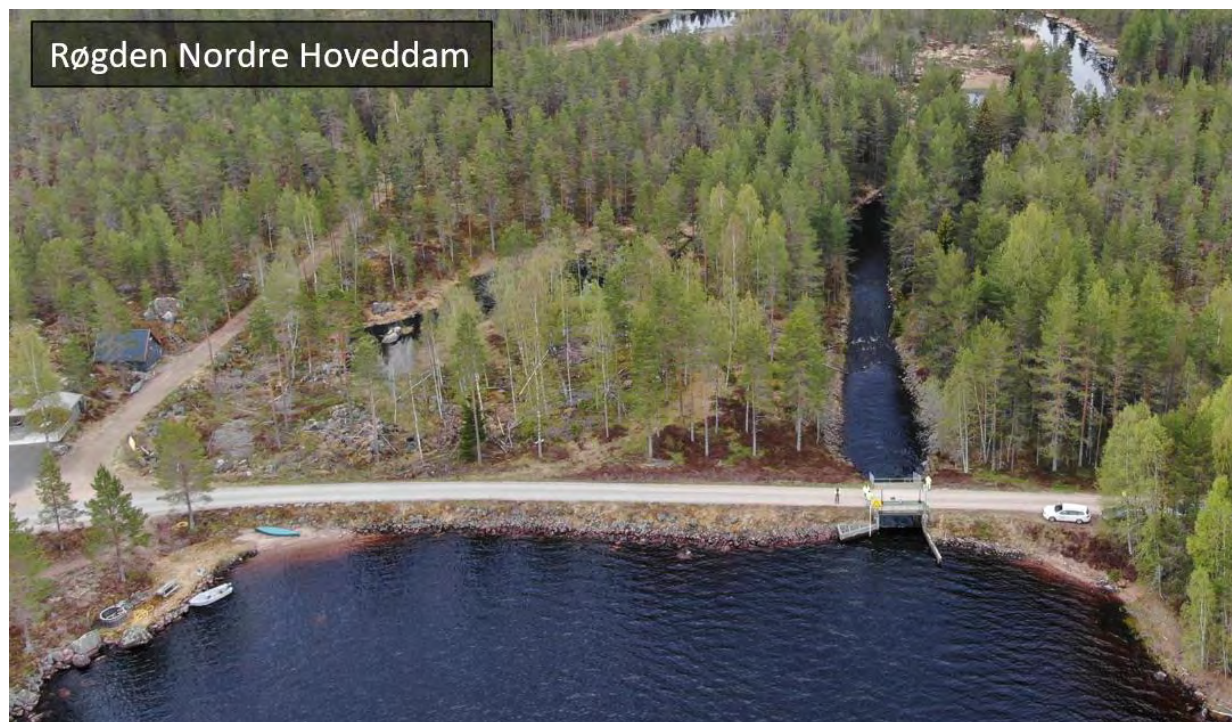
Figur 3 Røgden Nordre Hoveddam sett fra oppstrøms side.
