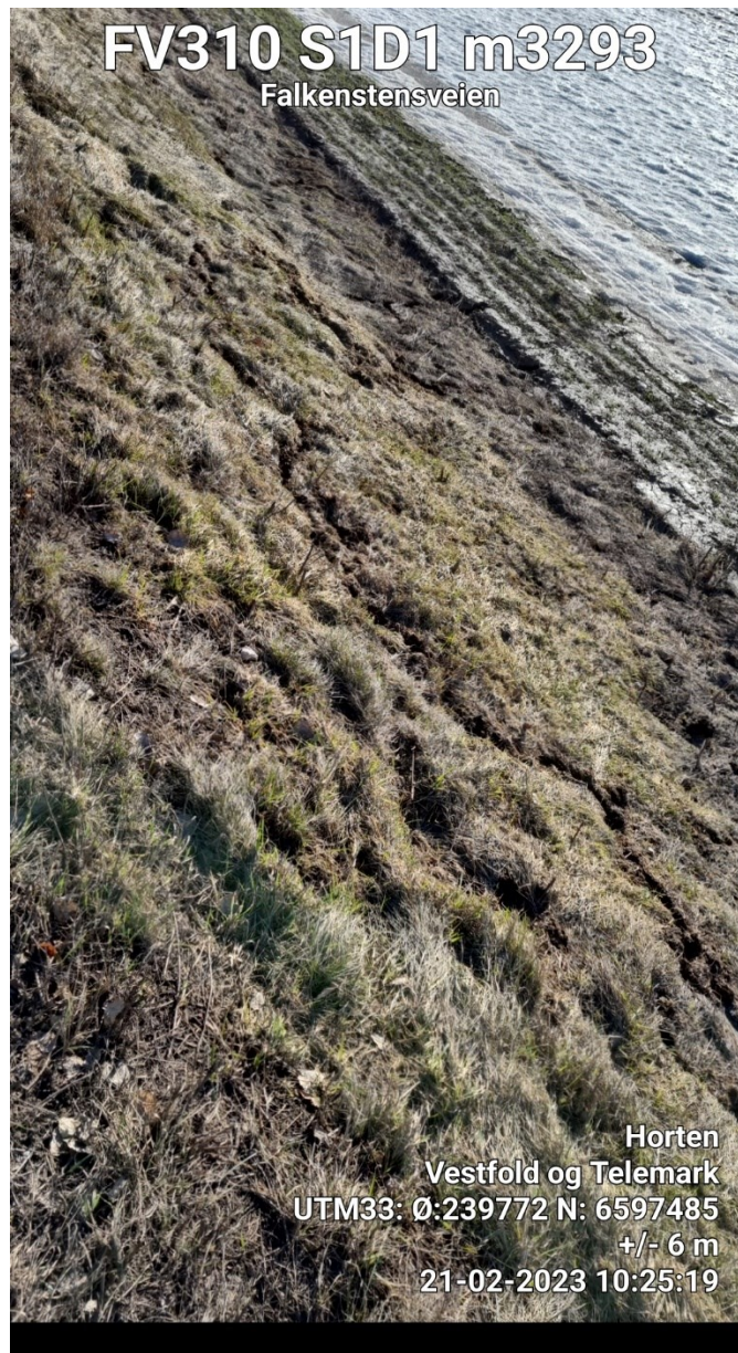
Figur 9 - Mulig erosjon på skråning langs veien
