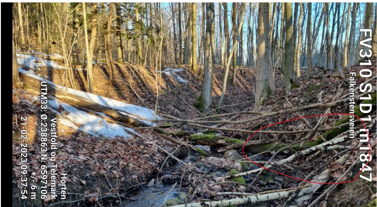
Figur 5 - Bildet er tok mot nordlige retning og viser synlige erosjon i røde sirkel
