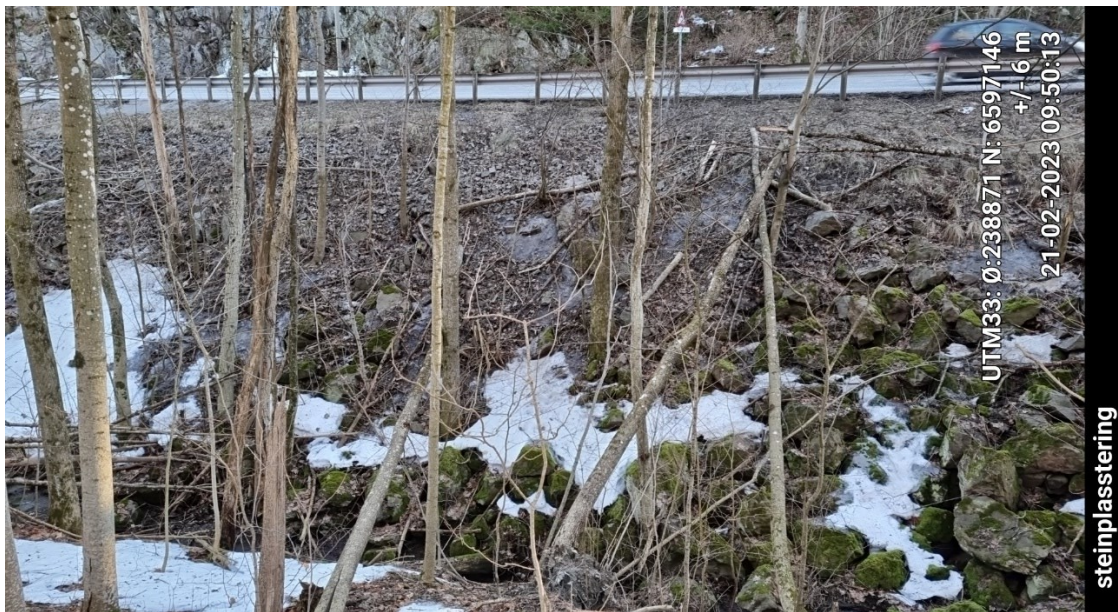
Figur 8 - Steinmasser langs veien
