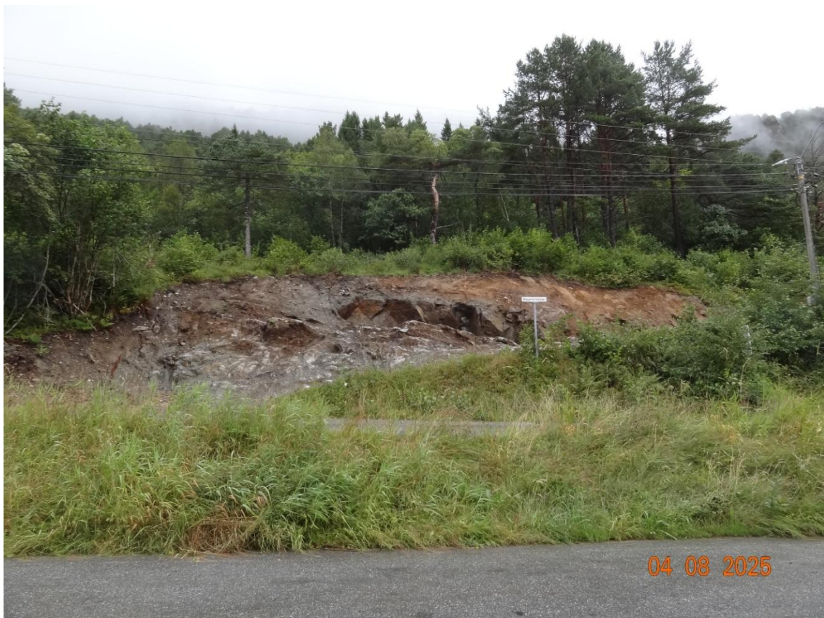
Figur 4 Bilde mot planområdet, påverknadsområdet i bakgrunnen. Planområdet der vegkryss skal utvidast er avdekt for lausmassar
