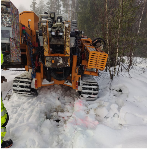
Bilde 4.6 Bilde av borpunkt A. Kilde: RGB (Romerike Grunnboring AS)
