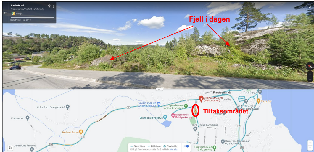
Bilde 4.3 Street view bilde fra vestlig del av tiltaksområdet viser fjell i dagen flere steder langs Heireks vei. Kilde: https://www.google.no/maps/?hl=no
