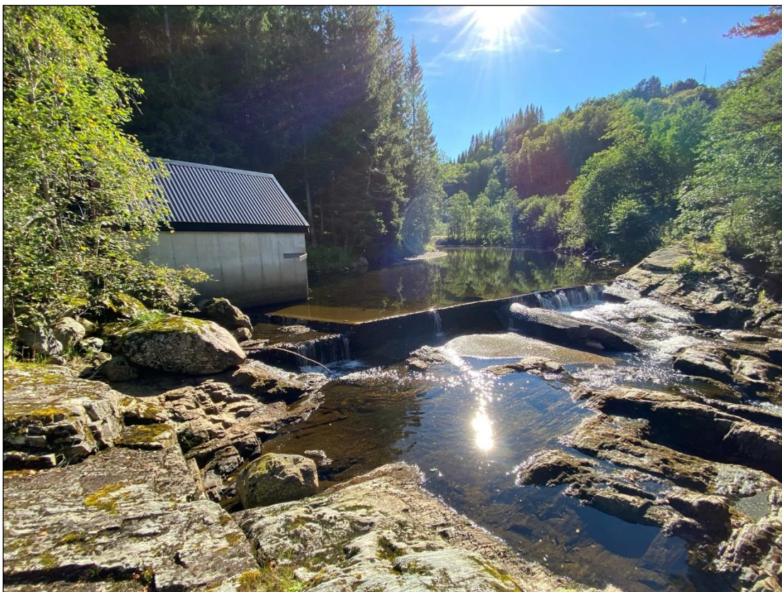
Figur 24. Fast fjell ved inntaket til Nedre Skorilla. Foto: Hywer AS.
