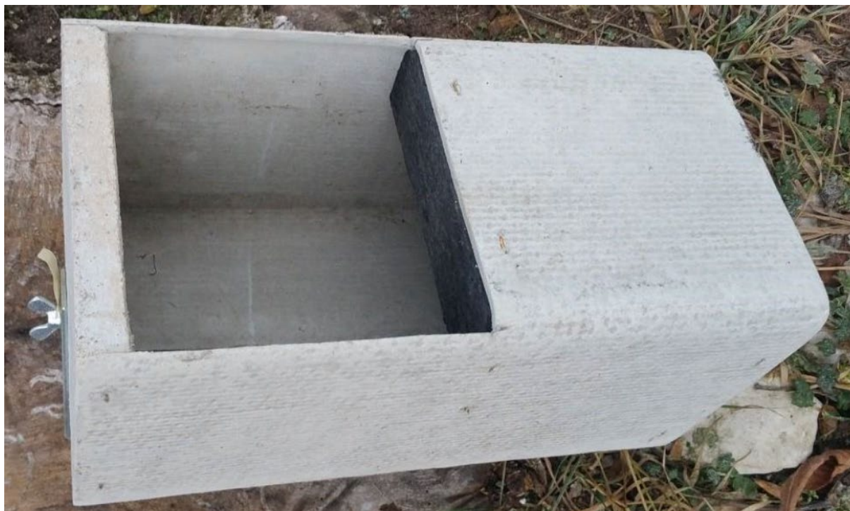
Figur 2-1 Eksempel på kasse for fossefall i betongtre for montering på egnet sted langs elvestrekningen
