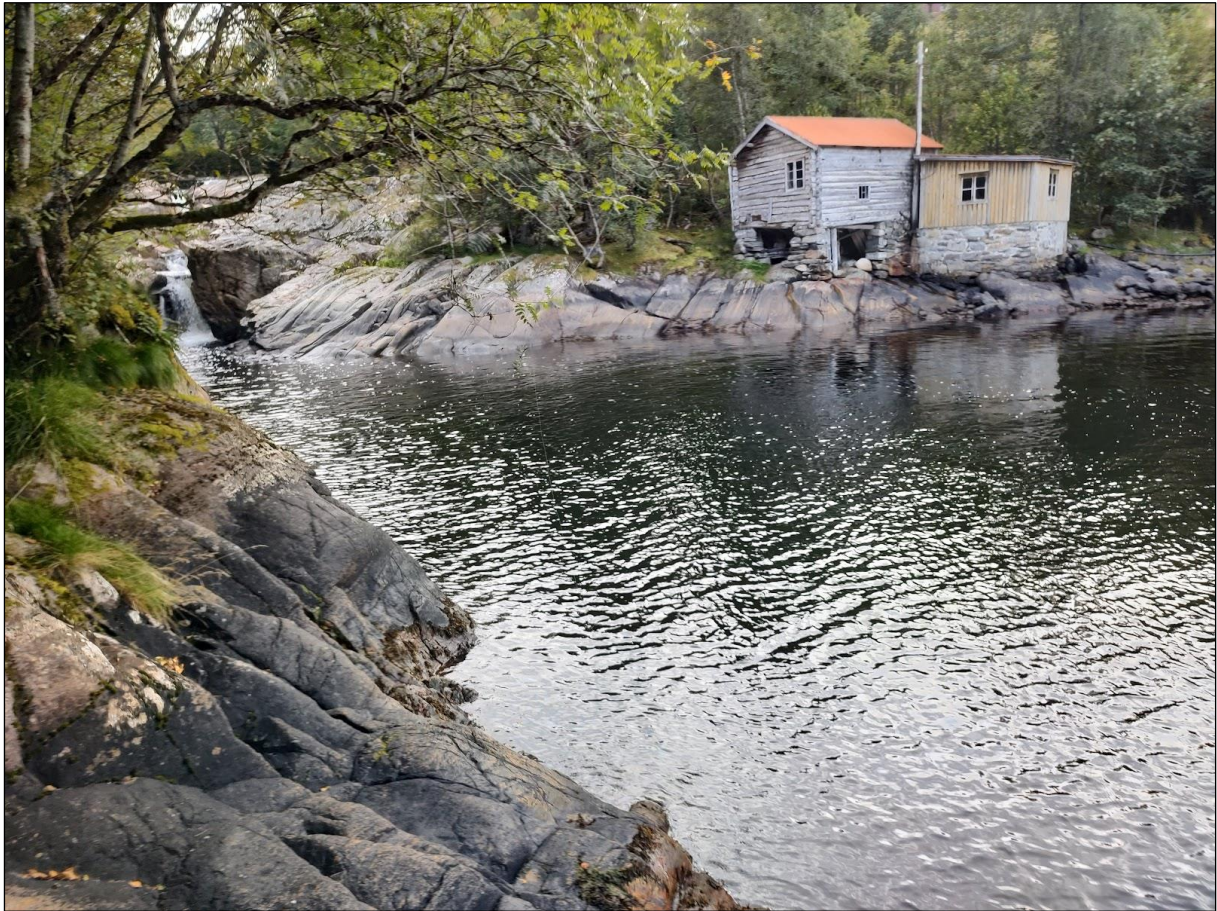
Figur 22. Fjell i strandsonen ved utløpet til Vuttudalselva. Planlagt plassering av nedre kraftstasjon er til venstre i bildet, på fast fjell.
