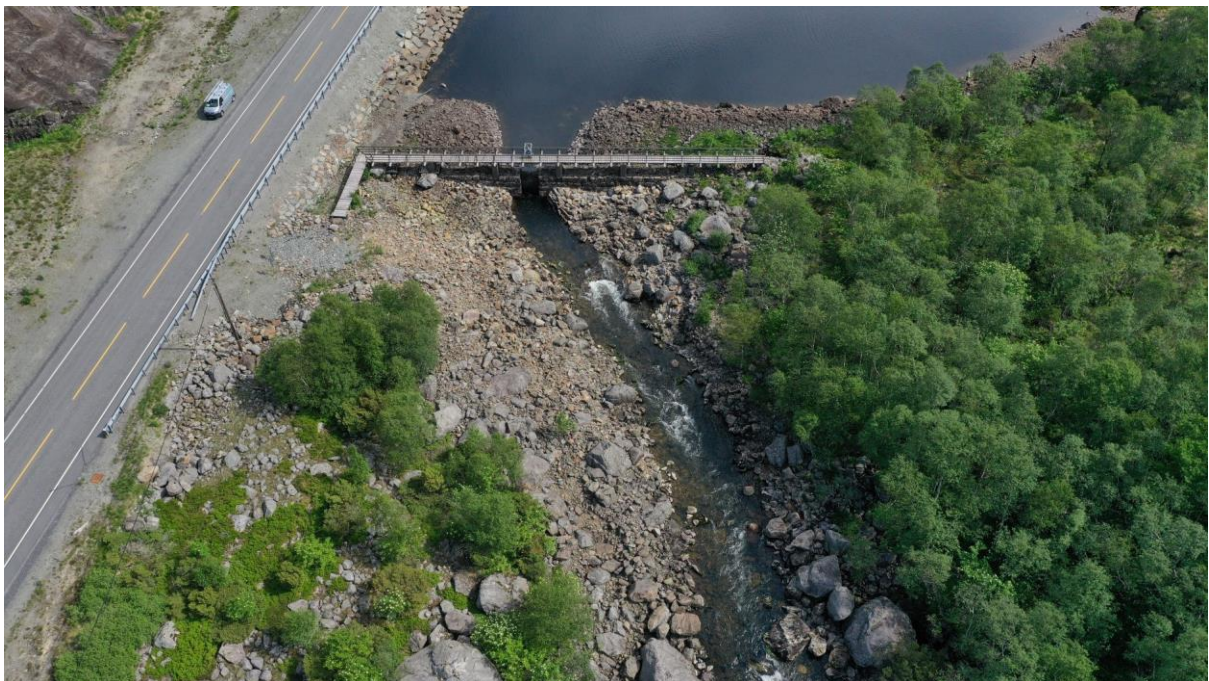
Figur 12. Situasjon ved utløpet av Gyavatnet, ved dam Gyavatnet 7. juni 2021. Vannstanden var på tidspunktet ca. 166,2, dvs. ca. 50 cm over eksisterende LRV.
