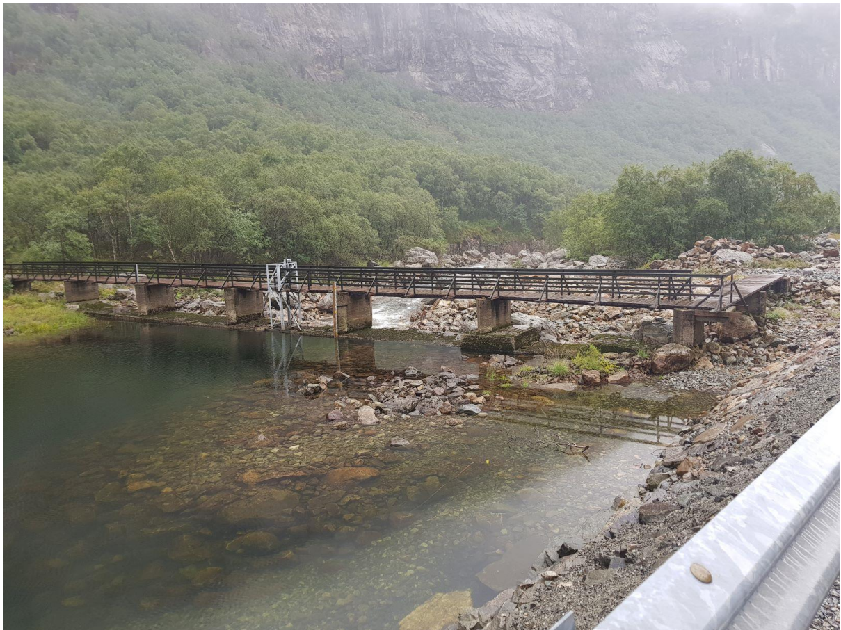
Figur 10. Situasjon ved utløp ved dam Gyavatnet 15.08.2018. Vannstanden i Gyavatnet var på tidspunktet ca. 168,1, dvs. ca. 10 cm under HRV.
