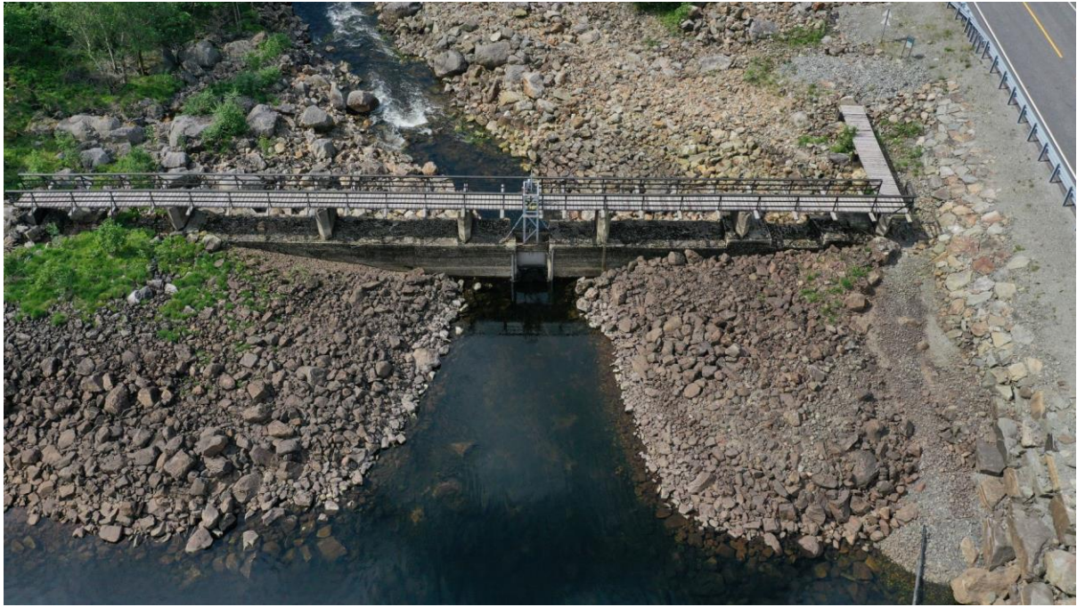
Figur 9. Utløp fra Gyavatnet ved dam Gyavatn. Bildet er tatt 7. juni 2021. Vannstanden på tidspunktet var ca. 166,2, dvs. 50 cm over eksisterende LRV.
