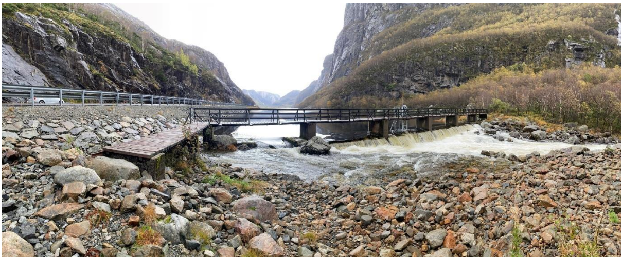
Figur 13. Situasjon nedstrøms dam Gyavatnet 09.10.2020. Det var overløp over dam Gyavatn på tidspunktet. Dvs. at vannstanden var over HRV.
