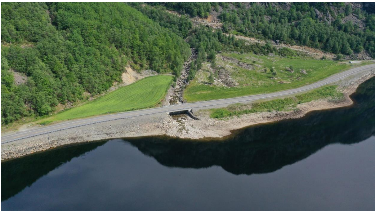
Figur 8. Oversikt over innløp fra elva Skinnellåna i østre del av Gyavatnet. Bildet ble tatt 7. juni 2021. Vannstanden i Gyavatnet var på tidspunktet ca. 166,2, dvs. ca. 50 cm over eksisterende LRV.
