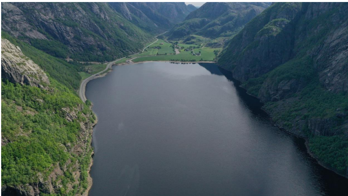
Figur 2. Oversikt over østlig del av Gyavatnet (innløp). Bilder tatt 7. juni 2021. Vannstanden i Gyavatnet var på tidspunktet 166,2, dvs. ca. 50 cm over eksisterende LRV.
