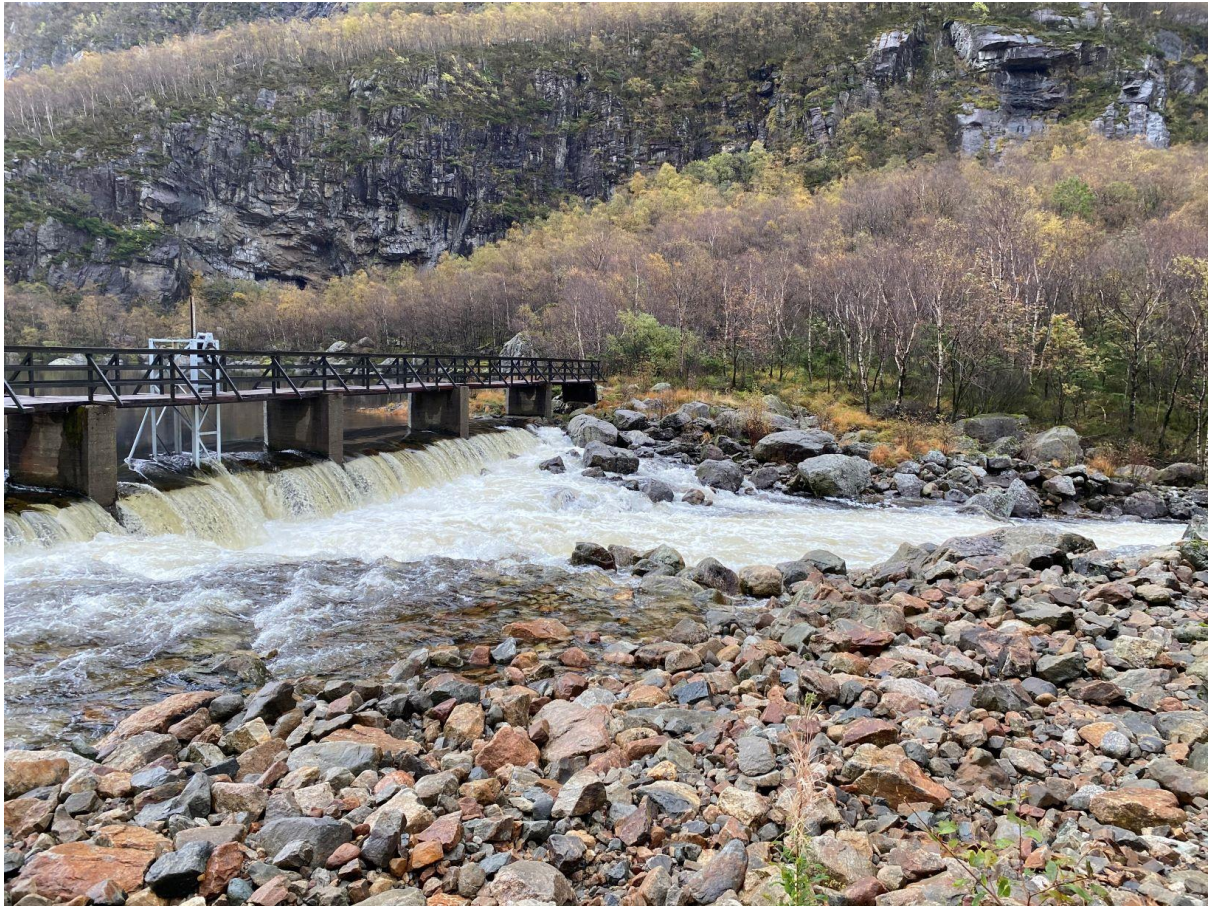
Figur 13. Situasjon nedstrøms dam Gyavatnet 09.10.2020. Det var overløp over dam Gyavatn på tidspunktet. Dvs. at vannstanden var over HRV.
