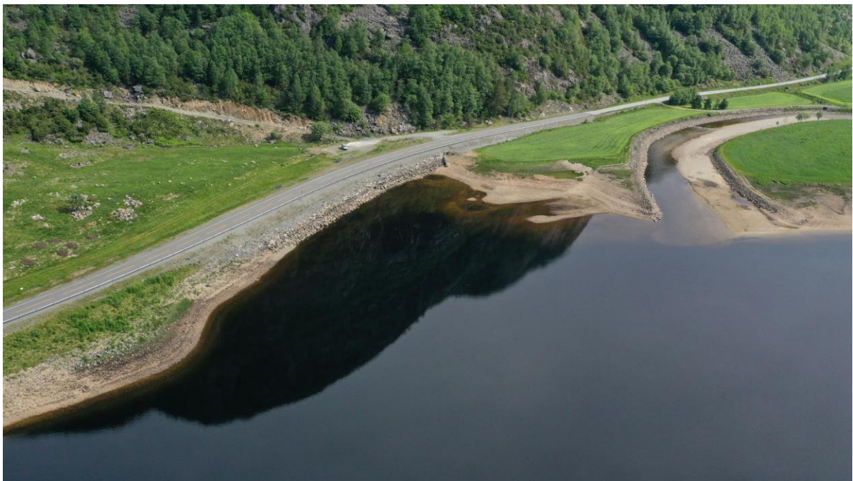
Figur 4 Juni. Oversikt over innløp fra elva Gya til Gyavatnet i den østre enden av vannet. Bildet er tatt 7. juni 2021. Vannstanden i Gyavatnet er på tidspunkt på kote ca. 166,2, dvs. ca. 50 cm over eksisterende LRV.
