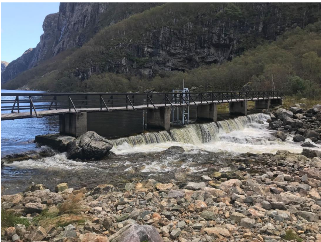
Figur 9. Dagens dam Gyavatnet. Vann slippes i overløp over dammen.
