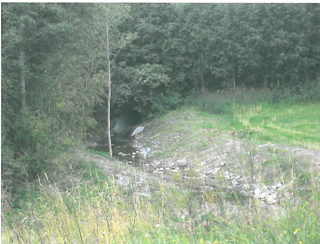
Innløp ved kulvert sett fra ca pel 70
