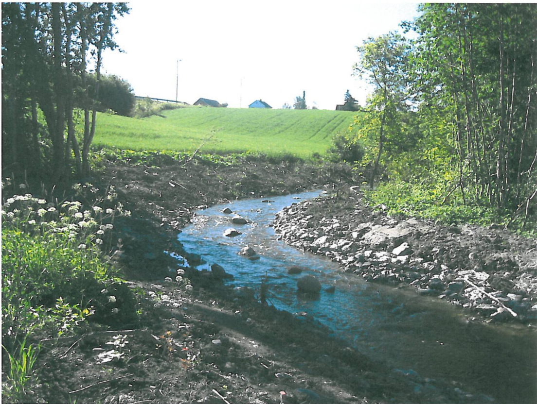
Sett oppover fra innløp gjennomstikk – ca pel 200
