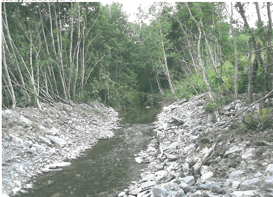
Sett mot øvre avslutning fra ca pel 510
