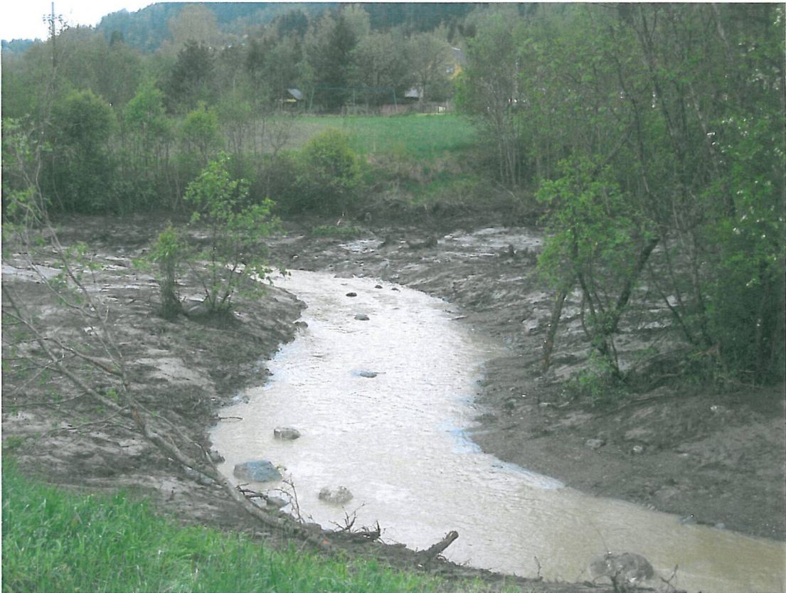
Gjennomstikk ved pel 180. Det gamle løpet er fylt igjen – barnehagen i bakgrunnen
