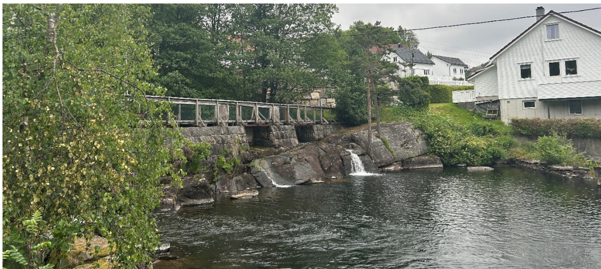
Figur 1: Eksisterende murdam skal fungere som fangdam under anleggsarbeidet, og ny dam er prosjektert rett nedstrøms. Den gamle dammen skal rives når den nye dammen er ferdigstilt.
