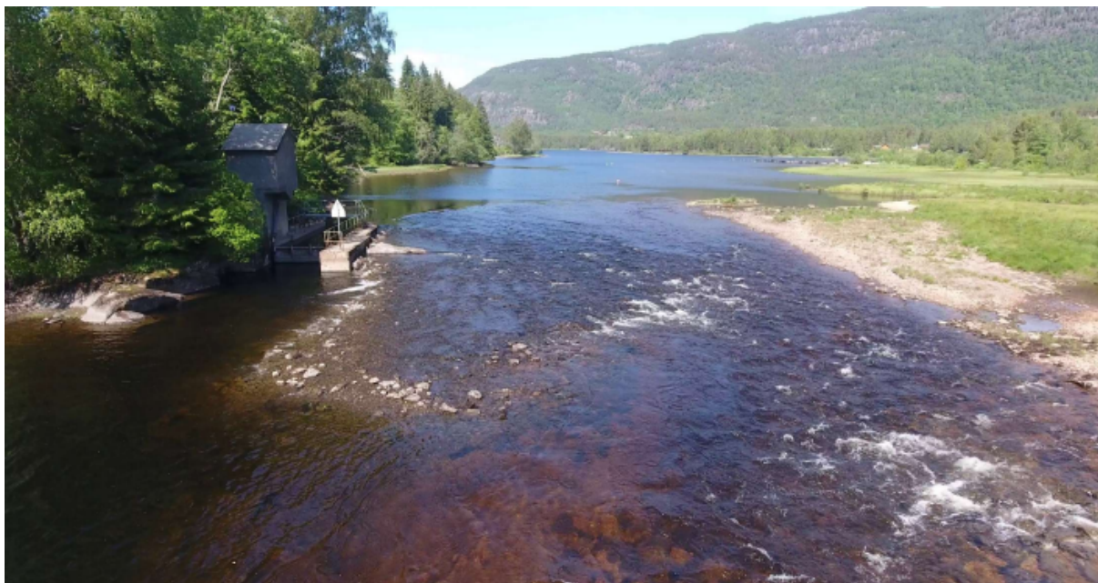
Figur 1. Foto av utløpet fra Seljordsvatn ved Hagadrag (fra dok. 56). Lukekonstruksjonen til venstre og naturlig terskel til høyre. Del av bergterskel kan skimtes like til høyre for lukekonstruksjonen.
