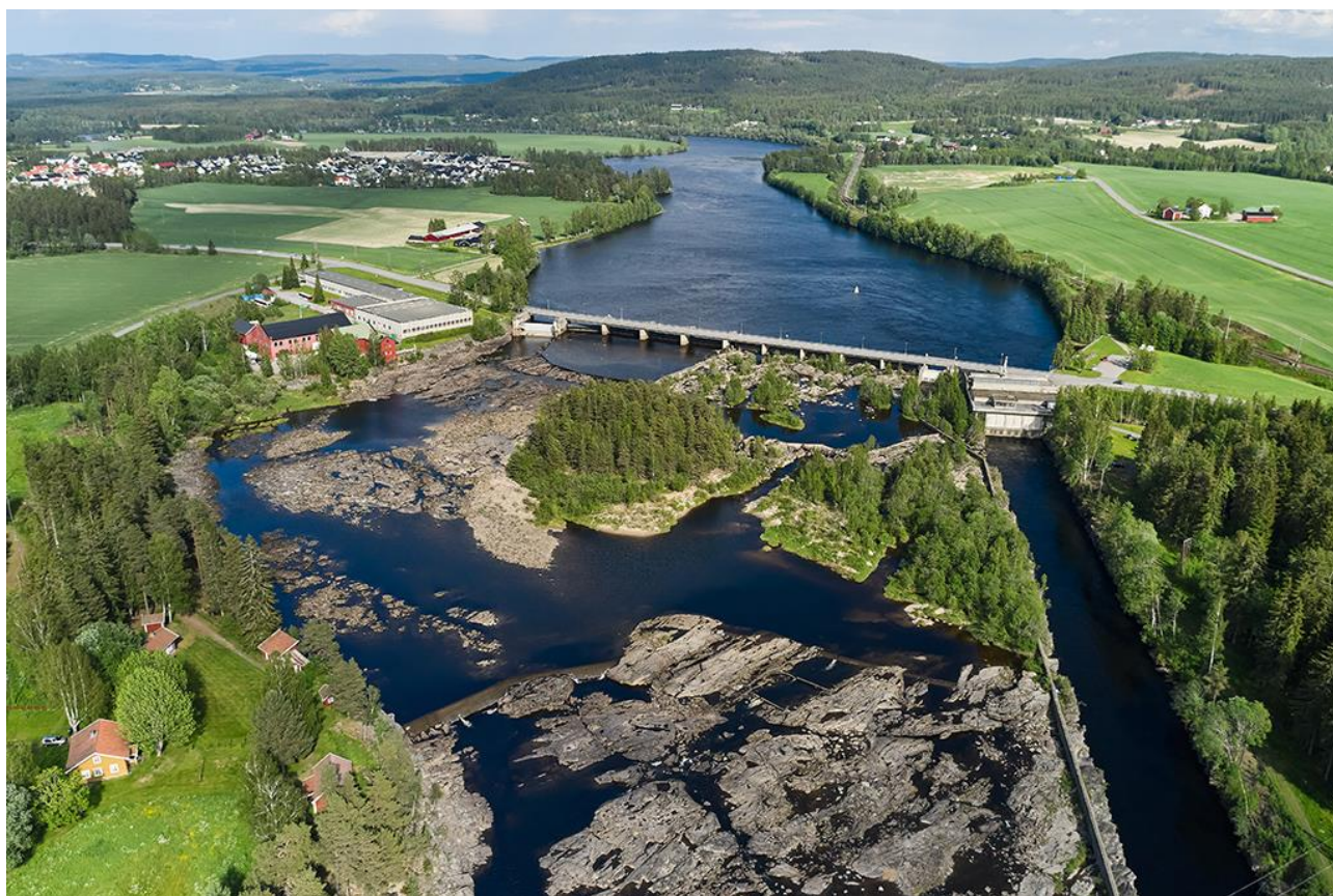
Vedlegg 1 Bilde av Funnefoss kraftverk og damanlegg uten overløp, men vannfylte terskler
