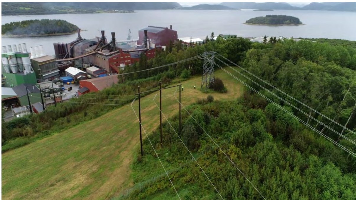
Figur 19. Kolhaugen. Kulturminnet 36344-1 er haugen mellom de to mastepunktene, der dagens 132 kV nærmest står innenfor sikringssonen, mens dagens 22 kV bortest står utenfor ny avgrensning av kulturminnet. Nytt mastepunkt planlegges lagt utenfor kulturminnet, ev. i dagens sikringssone dersom kulturminnet blir frigitt som følge av andre tiltak (utenom denne konsesjonssøknaden) i regi av Wacker Holla.
