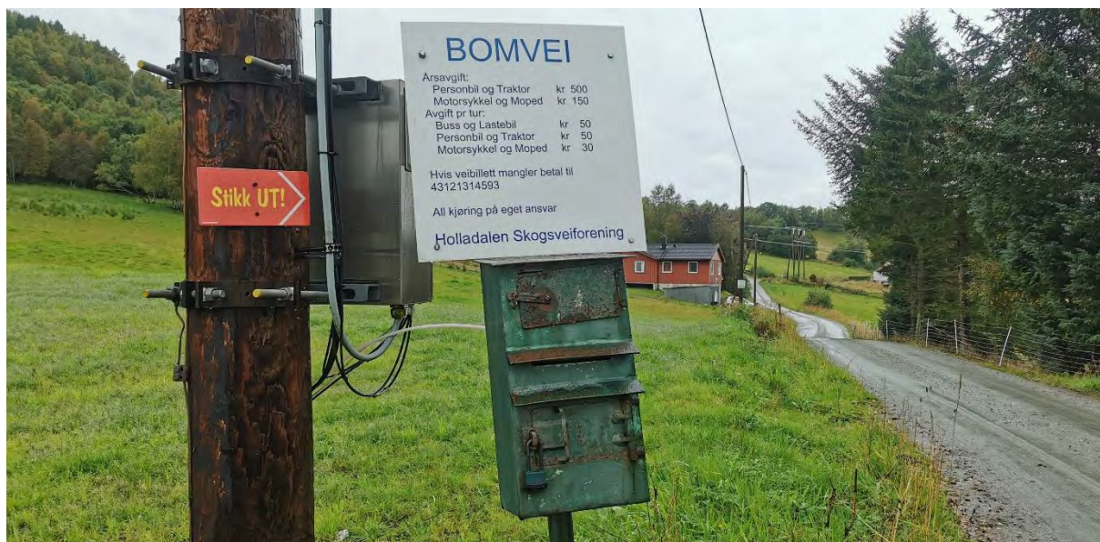
Figur 8: Turmerking langs Holladalsveien. Eksisterende 132 og 22 kV krysser veien, se bak til høyre for rødt hus.
