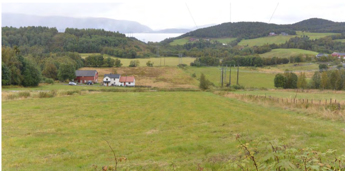
Figur 12: Sett fra dagens transformatoranlegg ned langs eksisterende kraftledningstraseer, som er godt synlige men ikke framtrepende i et sammensatt landskapsbilde.
