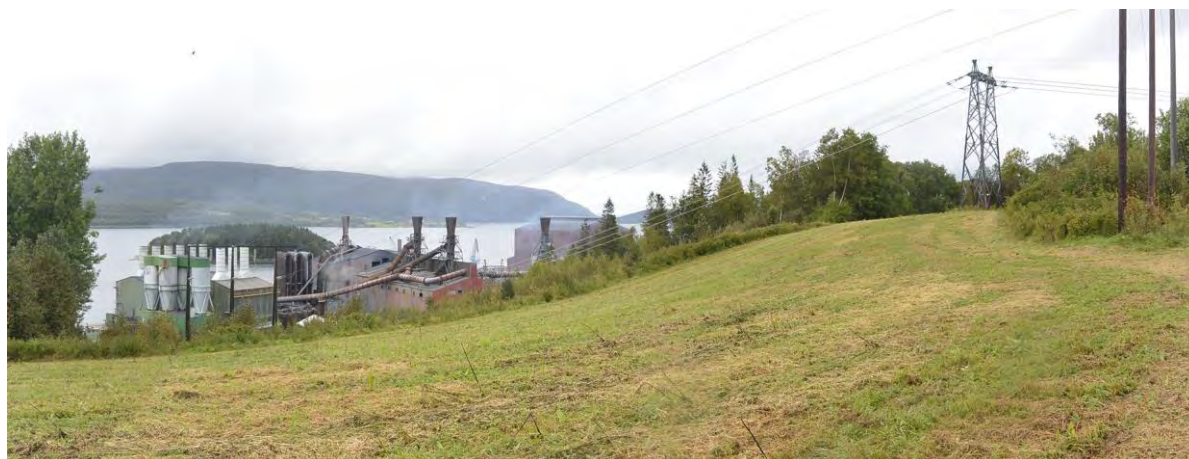
Figur 10: Mast 7 til høyre og fabrikkanlegget ved Holla Metall til venstre. Planlagt nytt innstrekkstativ vil ligge omtrent der tremasta er synlig ned mot fabrikk. Gravhaugen er tydelig arrondert i overflata. Det er i dag fylldyrka eng på arealet som er avmerka som kulturminne.
