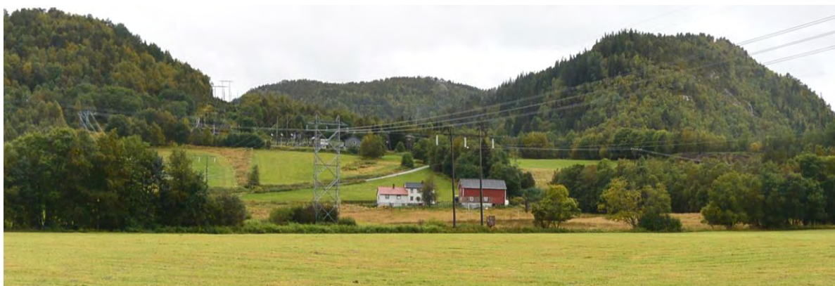
Figur 13: Sett nedenfra og tilbake/sørover mot eksisterende transformatoranlegg tar eksisterende kraftledningstraseer større fokus og er mer dominerende i et mindre sammensatt landskapsbilde. Fagverkskonstruksjonene har et mer industrielt preg enn tremastene og virker med det mer fremmede i jordbrukslandskapet med sterkt innslag av skog.
