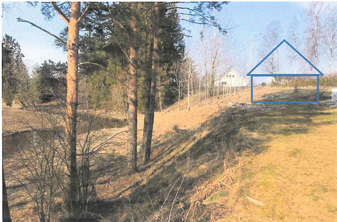
Figur 8 Skråningen har stedvis blitt noe brattere, men sikringen som er utført har bedret stabiliteten. Omtrentlig plassering av garasjen er inntegnet.
