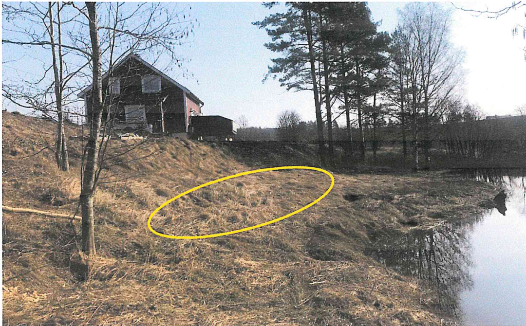
Figur 7 Blokker for å stabilisere skråningen etter utglidningen i 2014 er lagt ned i innringet område.
