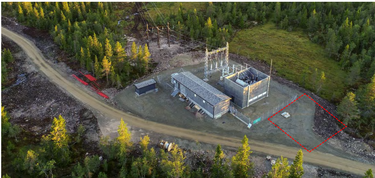
Figur 1 Luftfoto over eksisterende stasjon. Omsøkte tiltak vil endre uttrykket innenfor stiplede område (ikke eksakt).
