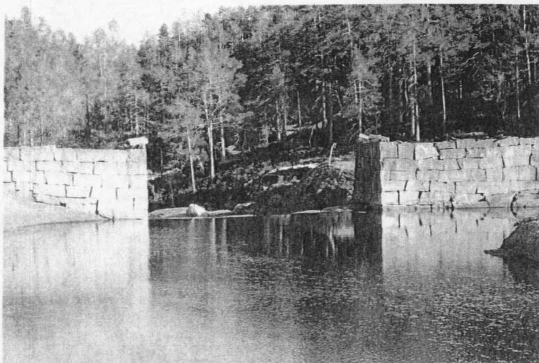
Stopstemmen som er utløpet av Høgelilona demmes opp 1 meter.
