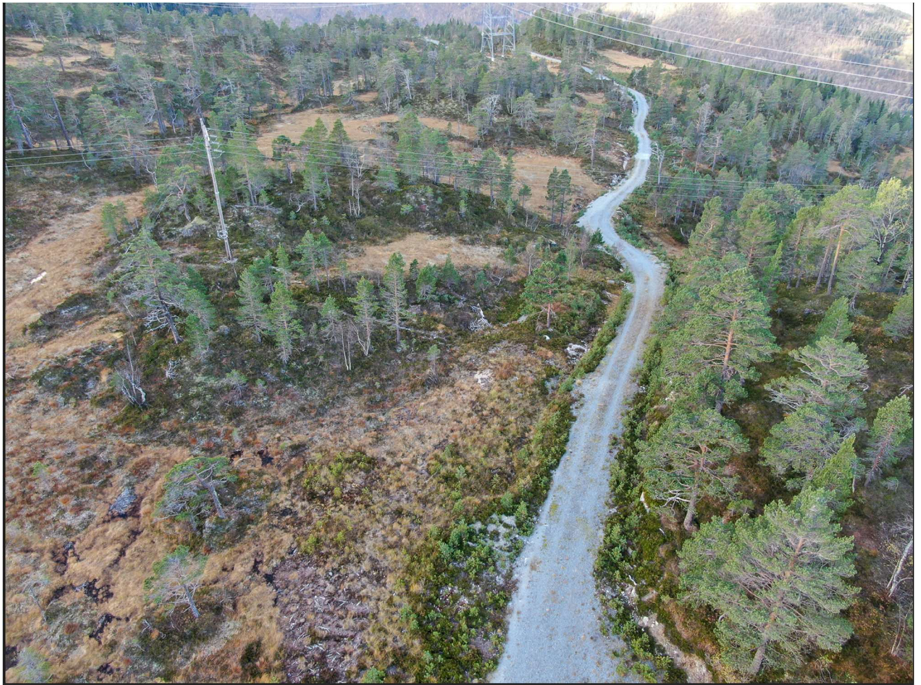
Dronefoto mot enden av Markavegen, i området for trommeplass ved mast M9. Foto: BKK
