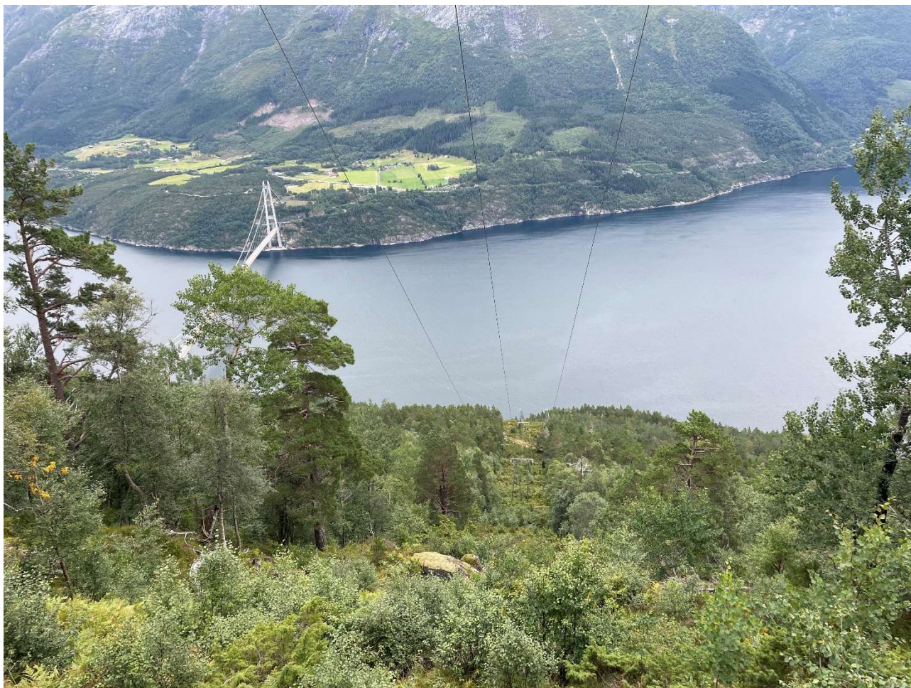
Foto fra mast M39 og nedover mot Hardangerfjorden. Foto: BKK
