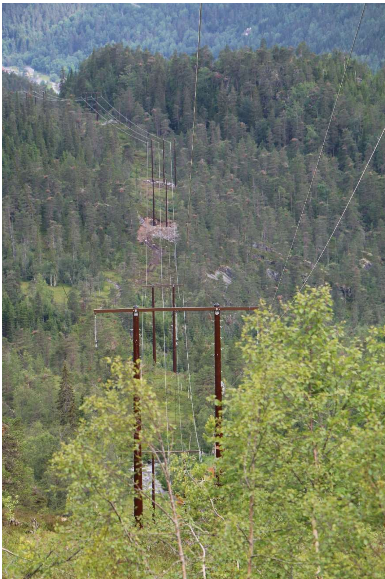
Komposittmaster av samme type på 132 kV kraftledningen Granvin – Voss. Foto: BKK
