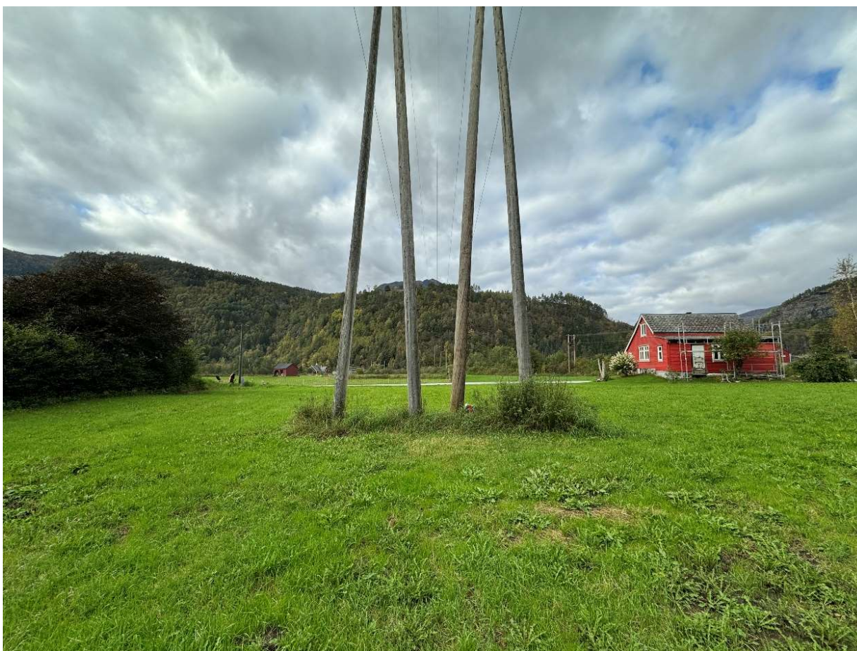
Mast 3 på slåtteteig nede i Granvin. Ett av de husene som ligger relativt nært ledningen, viser til høyre. Granvin transformatorstasjon ligger i bakgrunnen. Foto: Jøsok Prosjekt.
