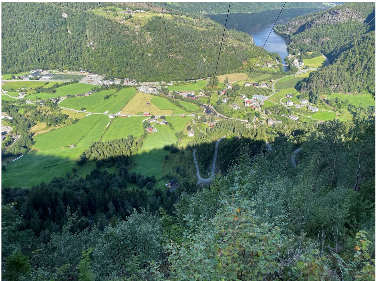
Foto over Granvin sett fra mast 5 og tilbake mot transformatorstasjonen. Foto: BKK
