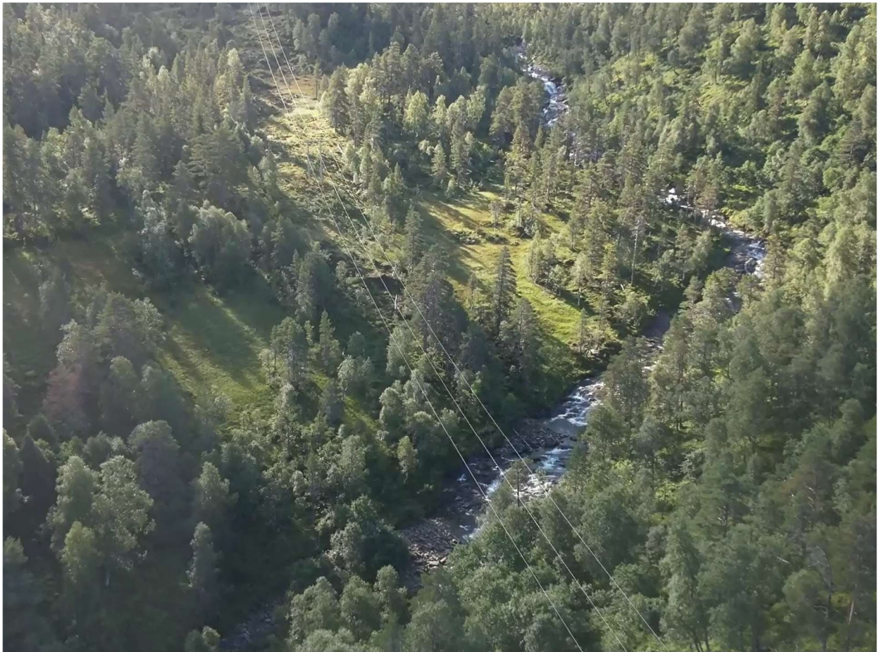
Foto fra elvekryssing mellom mast 16 og 17. Foto: BKK.
