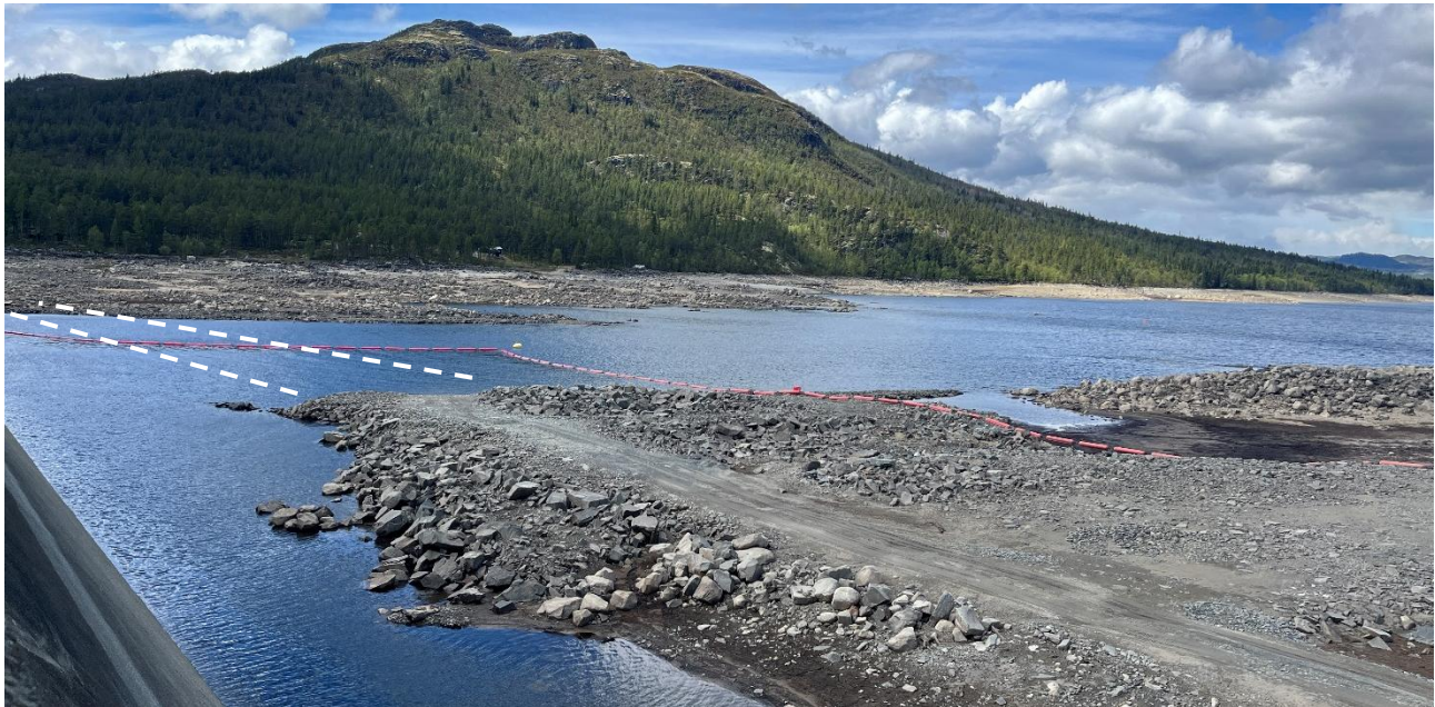
Figur 3-11. Bildet viser den eksisterende delen av midlertidig anleggsvei. De hvite, stiplede linjene viser hvordan fortsettelsen av veien er tenkt.
