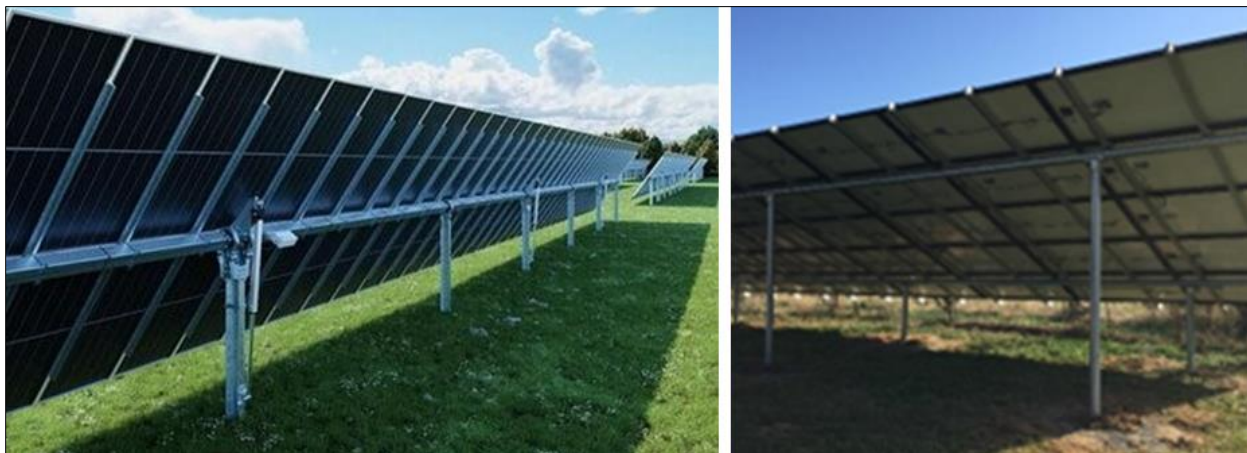
Figur 1-5: Eksempel på solcellemoduler med én-akse sporing (venstre) og solcellemoduler med fast montasjevinkel (høyre) (Solar, Trina) (Suncityenergy, u.d.).
