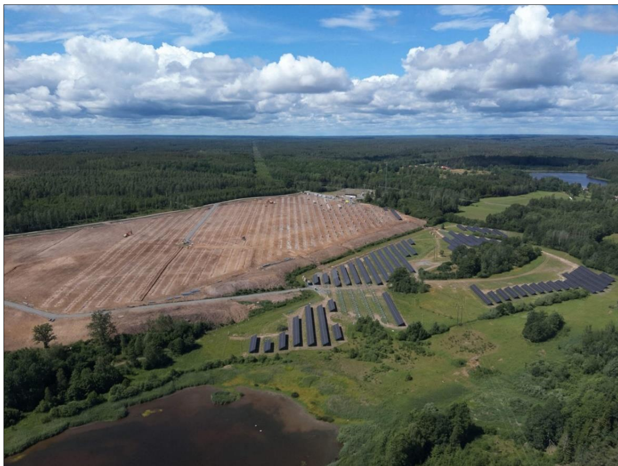
Figur 1-6: Bildet viser Mörghult solkraftverk (14,1MWp) i anleggsfasen. Dette er et av Solgrid sine prosjekter i Sverige. Til venstre i bildet er kraftverket under bygging. Til høyre i bildet er kraftverket ferdig installert.
