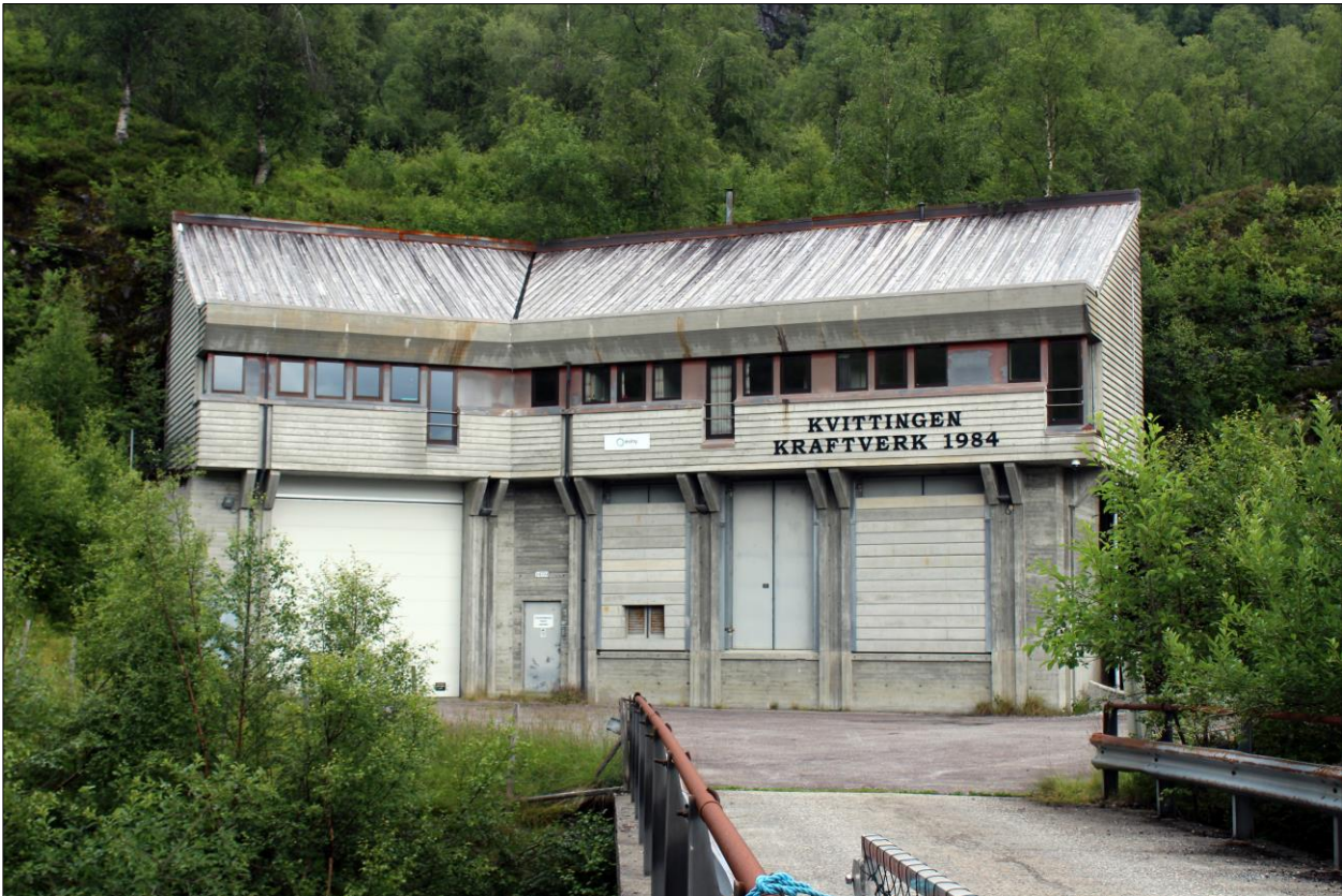
Figur 4-8. Kvittingen kraftverk. Foto: Jan Adriansen, Sweco.
