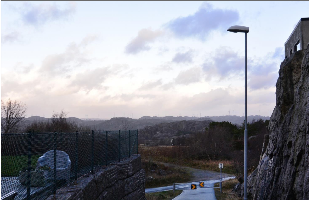
Figur 5-74: Foto mot tiltaksområdet for Moifjellet vindkraftverk, sett fra Sirevåg. Skinansfjellet og Gravdal vindkraftverk og Bjerkreim vindkraftverk er synlig herfra.
