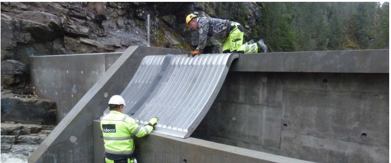
Figur 13 Montering av coandarister. Vanleg slukeevne 150 - 200 liter/sek/meter.
