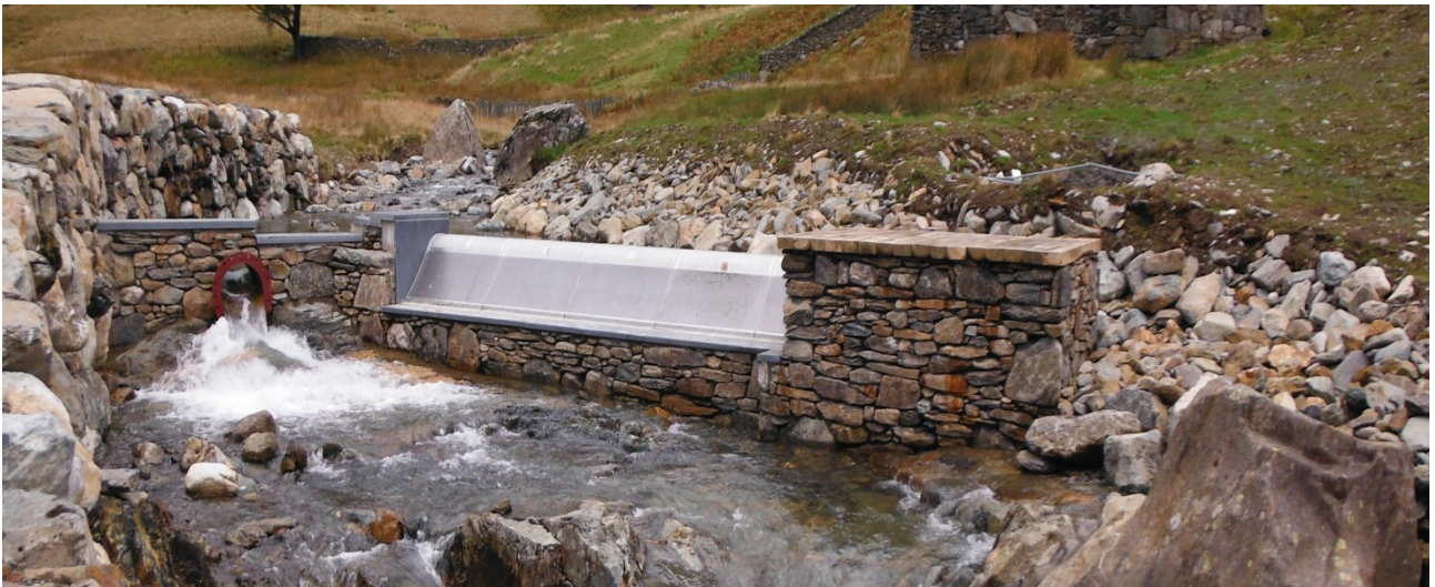
Figur 12 EKSEMPEL: Betongdelen av coandainntak kan med fordel forblendast med skifer og/eller naturstein.
