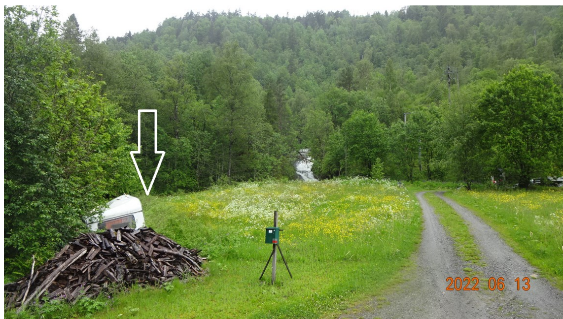
Figur 40 Omsøkt ny kraftstasjonslokasjon
