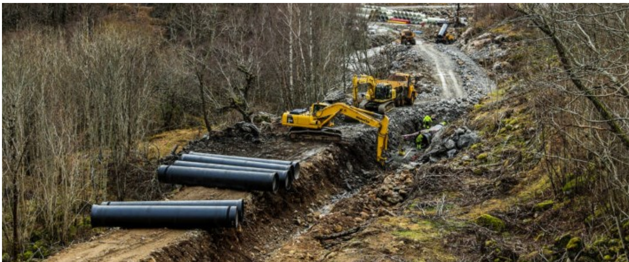
Figur 17 Eksempel på anleggsveg som tilkomst til inntak parallelt med røyrkata. Krev god logistikk og planlegging.
