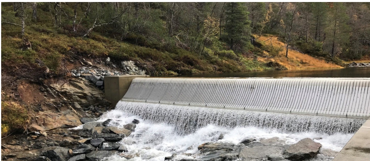
Figur 10 Coandainntaket i Vossadalselvi fungerer fint seier grunneigar Ivar Hernes, som også var med i planprosessen der.
