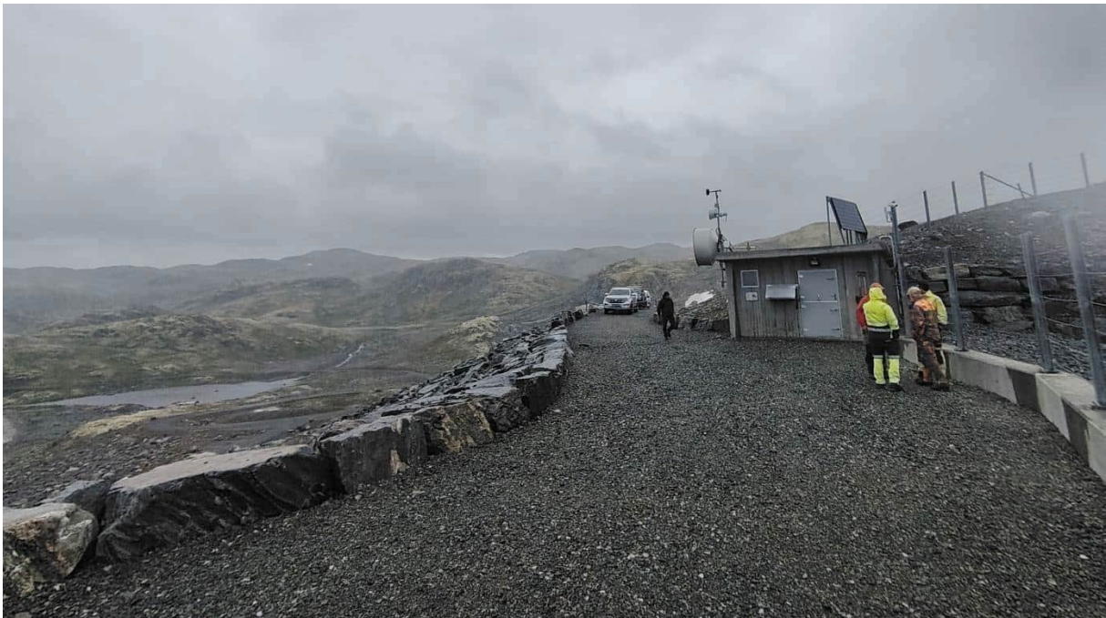
Figur 3-2 Befaring på damkrona ved Kvevatnet.
