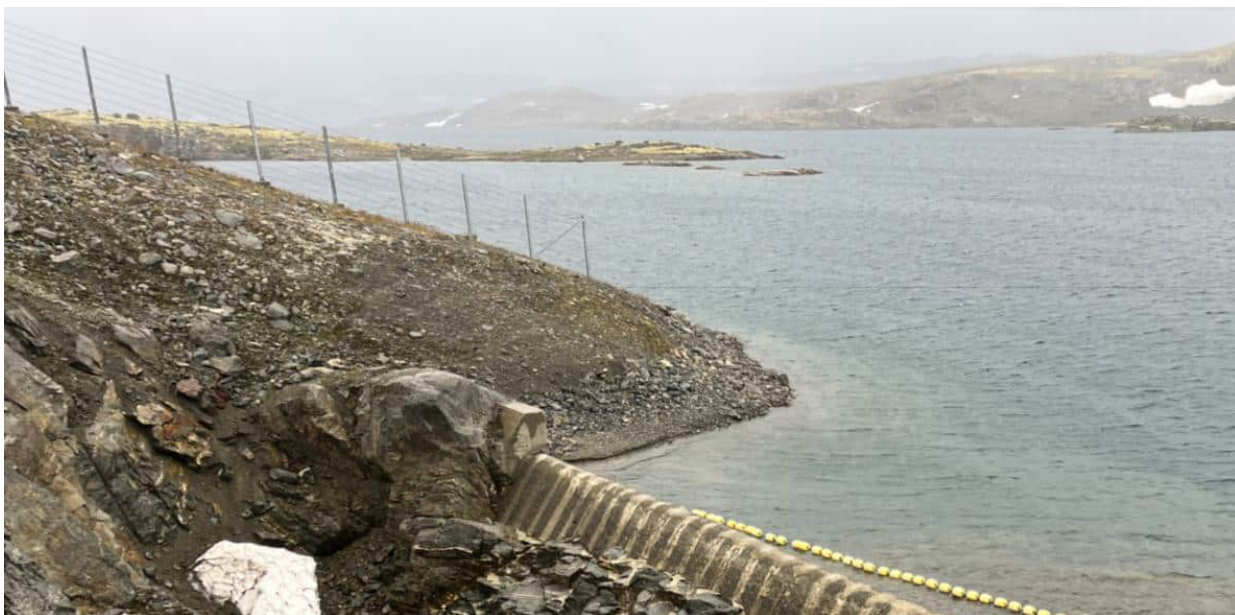
Figur 3-2. Bilde fra dam Kvevotni. Tilsvarende gjerde skal settes opp ved Øljusjøen.
