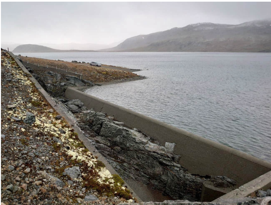
Figur 3-3. Overløpsterskelen ved dam Øljusjøen sett fra dammen. Det settes nye bolter i betongen, og selve trauret senkes i øverste del. Wire-gjerdet i bakgrunnen vil bli høyere.
