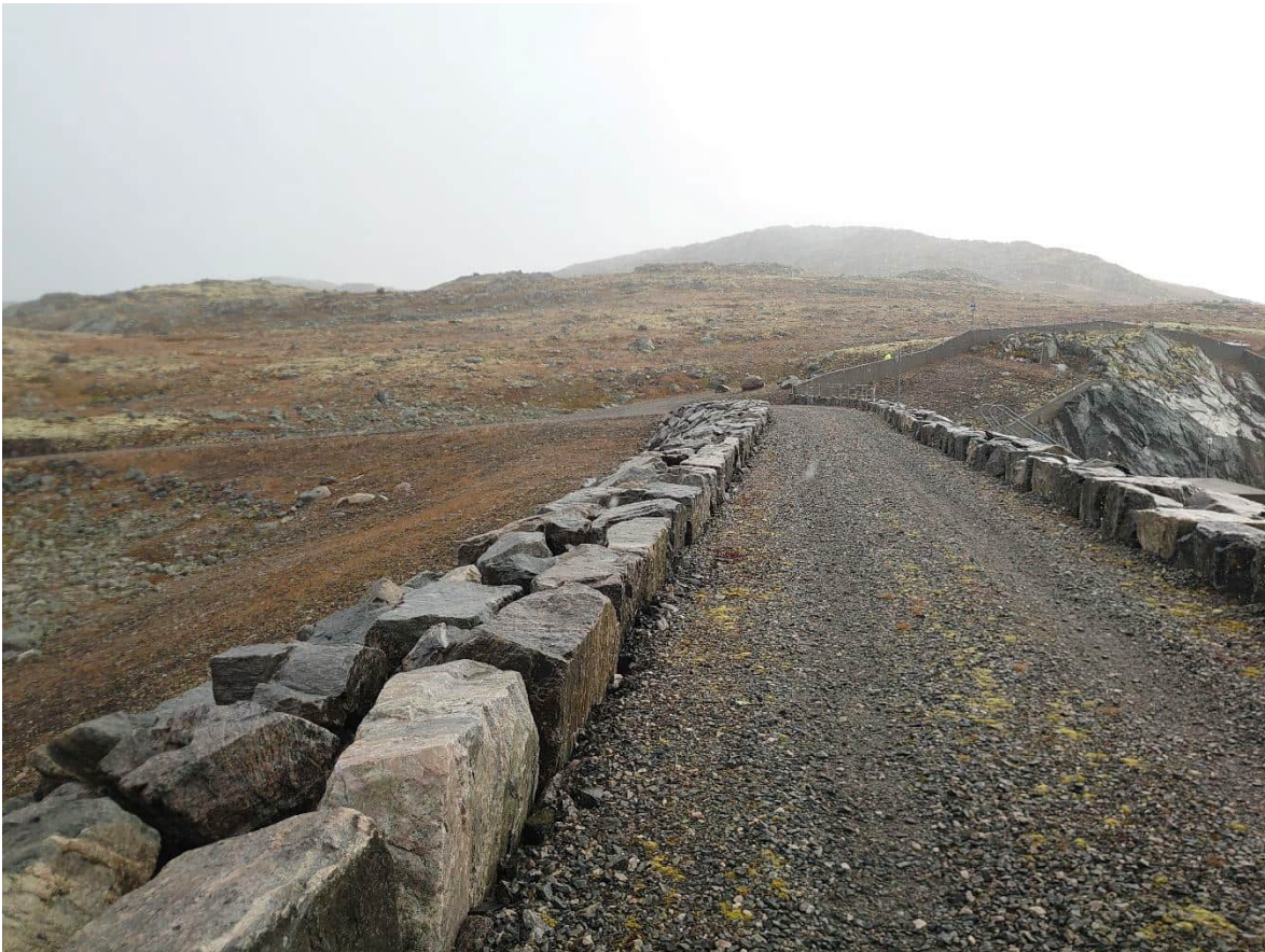
Figur 2-1. Bilde tatt fra dammen. Oppstrøms side og overløp kan skimtes til høyre i bildet.
