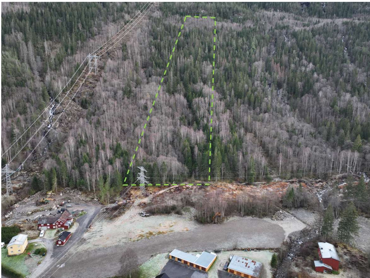
Figur 1-2: Omtrentlig skisse av skogskorridoren som skal fjernes. Skogskorridoren skal ha en bredde på omtrent 60 m.
