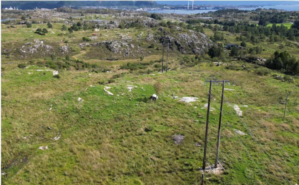
Figur 7: Trasé for ny 132 kV luftledning hvor denne vil gå parallelt med eksisterende 22 kV ledning på dens venstre side i forhold til bildet over. Fotografiet er tatt østover mot Raunholmen og Skipavika. Foto: BKK
