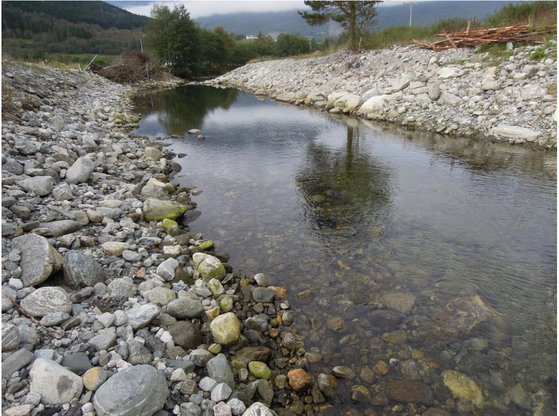
Figur 12. Sone D har et løp som er sterkt bearbeidet og utformet som et fordrøyningsbasseng.
