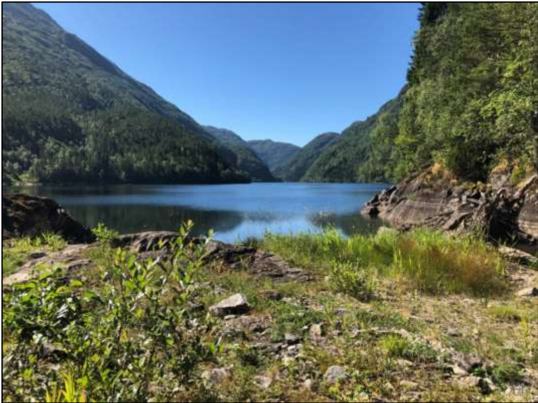
Osdalsvatnet ca. 1,5 m under HRV, sett frå overløpet
