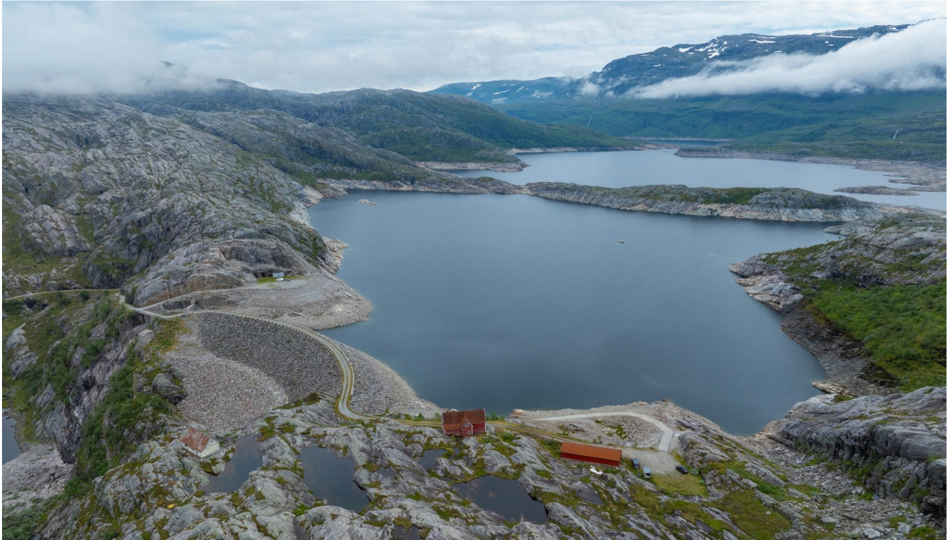
Bilde 2. Dronefoto av Svartavatnet/Holmavatnet tatt mot øst. Dam Svartavatn i forgrunnen. Allerede opparbeidete områder planlagt brukt som riggområder sees bak dam, og bak til høyre for hus i forgrunnen. Foto: Sweco. 12.07.2024
