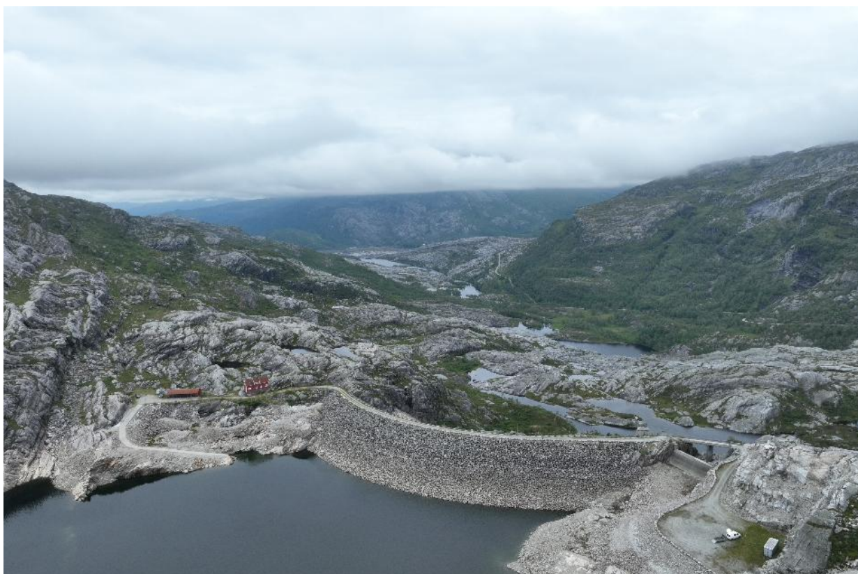
Figur 2-25 Eksisterende anleggsveg ned i magasinet benyttes som adkomst til arbeidene med lukehus og kanalisering. Bilde: Sweco.
