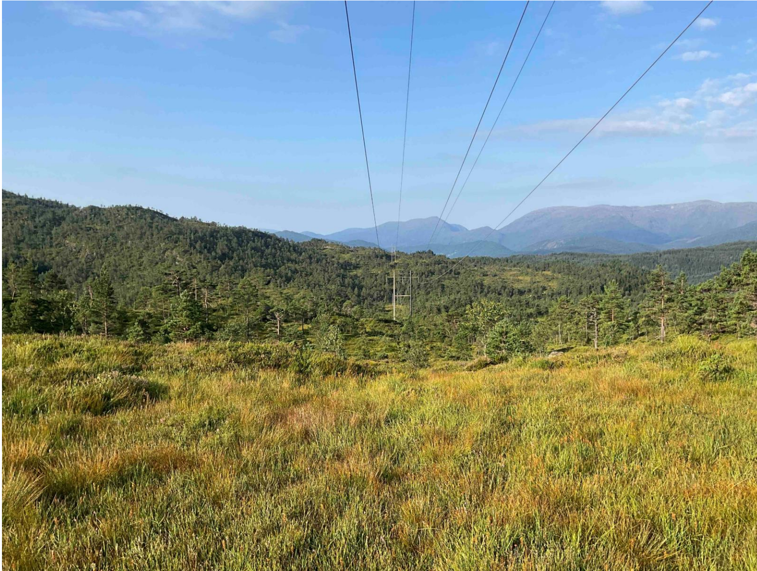
Bilde 11. Bildet viser eksisterende 132 kV luftledning som skal saneres til Frøland. Bildet er tatt fra rett sør for Svendsalsåsen mot sørvest. Foto: Sweco. 14.08.25.
