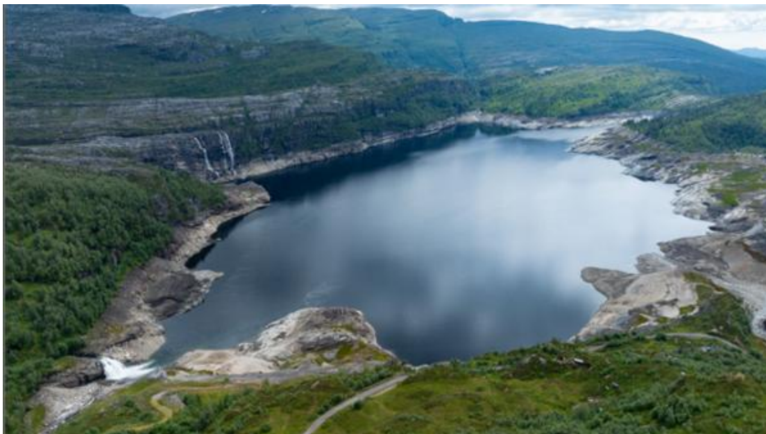
Figur 2-9 Utløpet fra eksisterende Kvittingen kraftverk kommer ut rett under HRV i Kvitingsvatnet. Fossene til venstre i bildet får vann fra restfeltet nedstrøms Svartavatnet. Bilde: Sweco.
