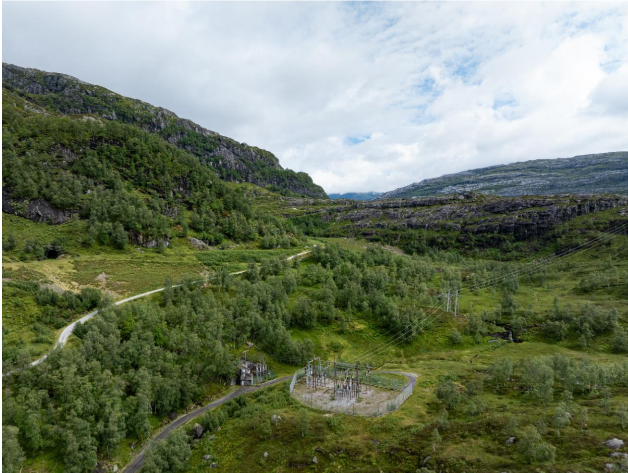
Bilde 6. Dronebildet av dagens koblingsanlegg, med eksisterende massetipper bak, for Kvittingen kraftverk. Nytt koblingsanlegg for Sotabotnen kommer i tilknytning til dagens anlegg. Eksisterende tipper er satt av til mulige riggområder. Foto: Sweco. 12.07.2024
