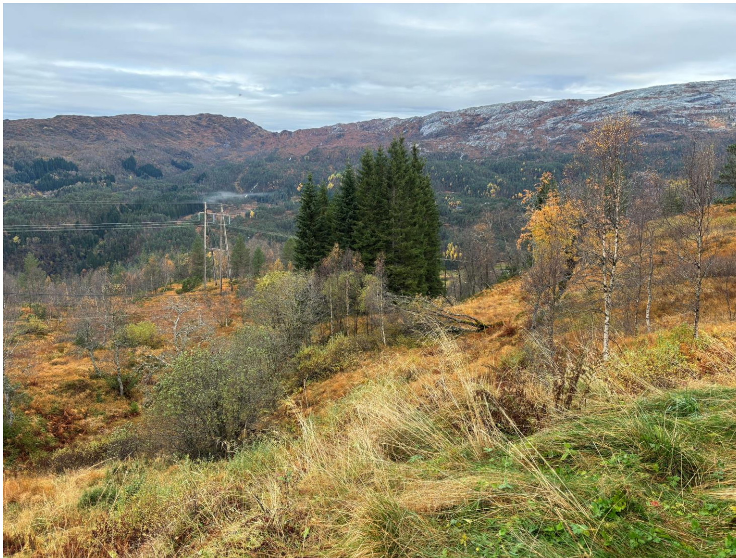
Bilde 10. Bildet viser eksisterende 132 KV luftlinje forbi Leitet. Nettilknytning for Sotabotnen, alternativ 2 Leitet, vil innebære at mast i bildet byttes med ny kabelendemast, og at dagens luftlinje saneres fra denne og mot venstre i bildet (til Frøland). Nettilknytningen vil deretter gå gjennom borehull ned til adkomsttunnel for planlagte Børdalen kraftverk og gjennom disse ned til Børdalen. I forbindelse med Børdalen kraftverk vil det komme et massedeponi i søkket til høyre for masten. Foto: Sweco. 14.10.25.
