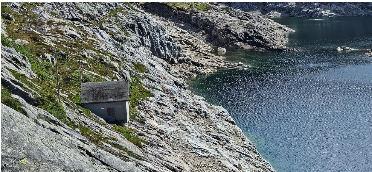
Figur 2-7 Eksisterende lukehus ved Svartavatnet. Nytt lukehus blir liggende nordøst for det eksisterende, og vil bli noe større, men med en tilsvarende utforming. Bilde: Sweco.
