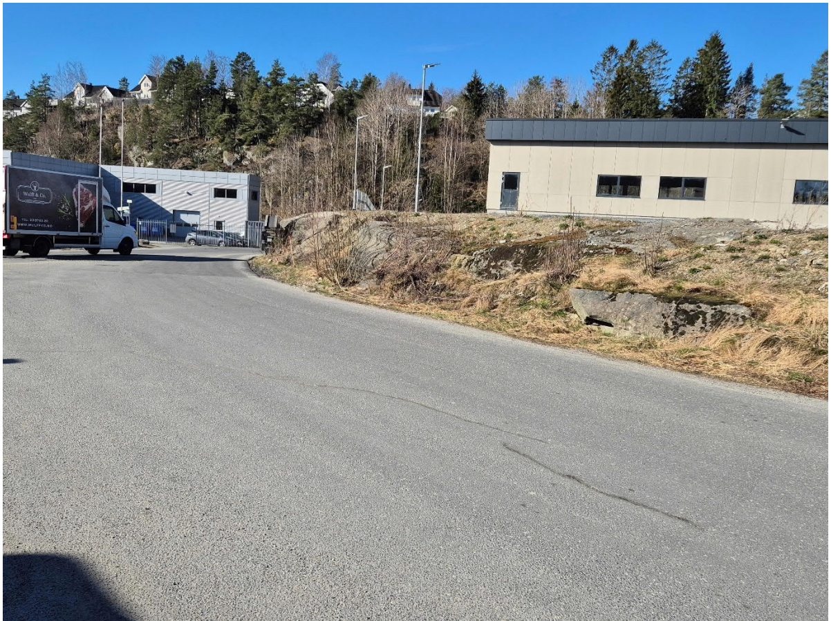
Berg i dagen langs Holterkollveien
