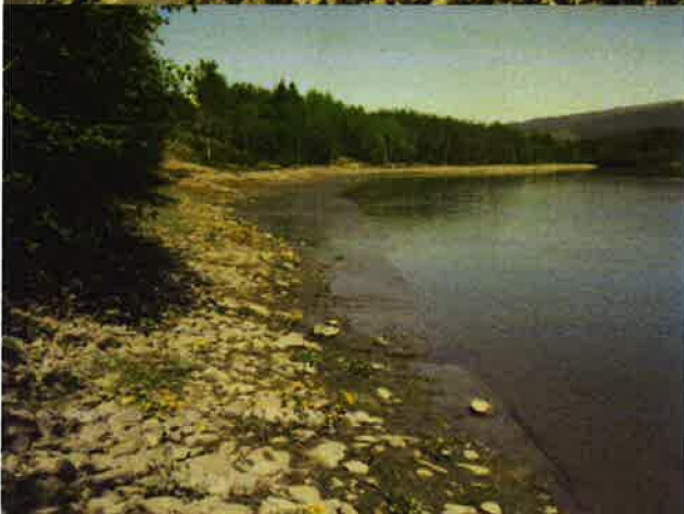
Røssåga sett medstrøms. Sikringstiltaket VV9972 Trongmoen ses i bakgrunn.
