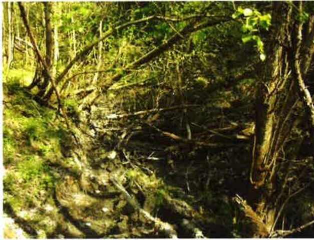
Sjøbekken rett ovenfor FV321 kulverten.
