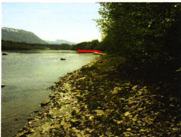
Røssåga sett motstrøms ved eksisterende anlegg: VV 7961 Solbakken. Det nye sikringstiltaket markert med rød strek.
