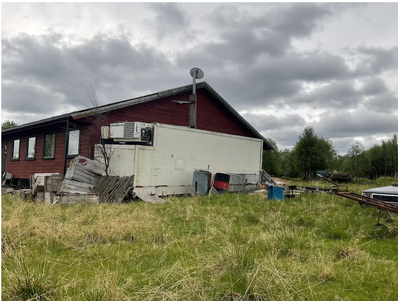
Figur 4-19: Det er mye bygningsmasse, skrot og tekniske installasjoner som nå er under riving. Sør-Fron kommune følger opp at bygg og avfall fjernes fra området.
