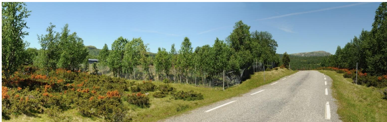
Figur 4-13: Før-bilde av tiltaksområdet sett fra Kilevegen i retning nord.
