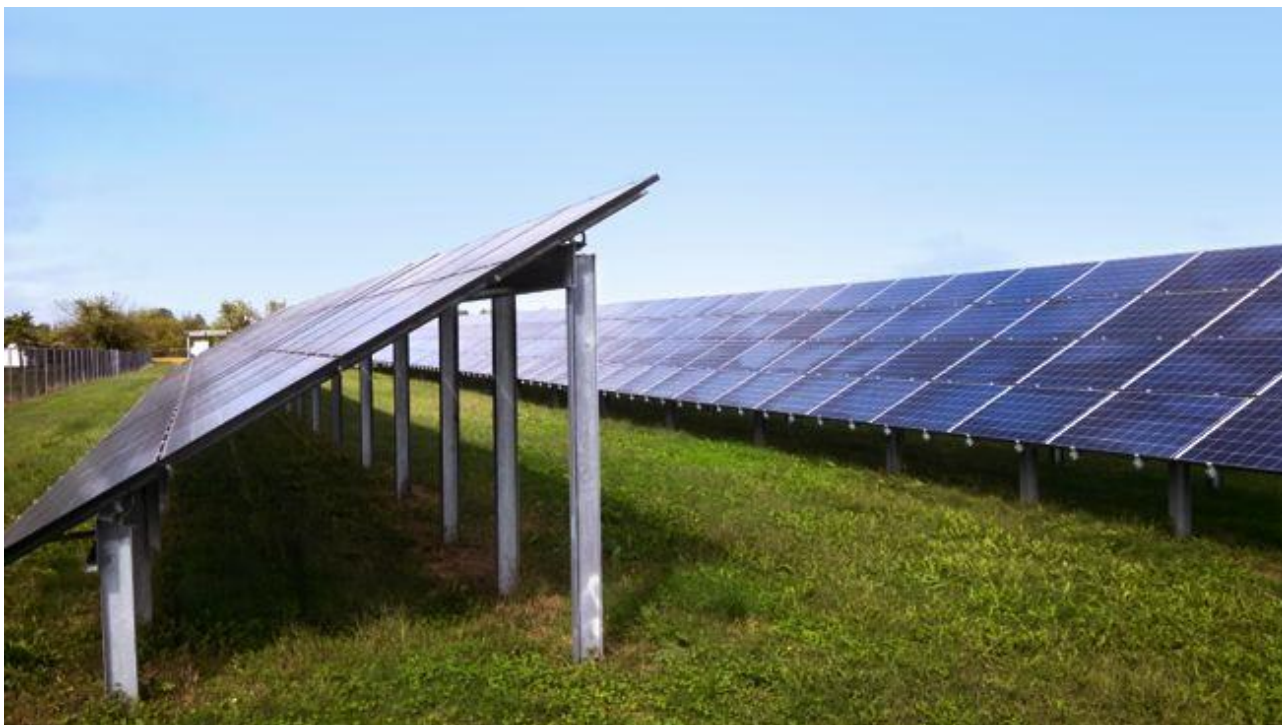
Figur 2-4: Fast-vinkel installasjonsløsning (foto: Willowbrook Solar)
