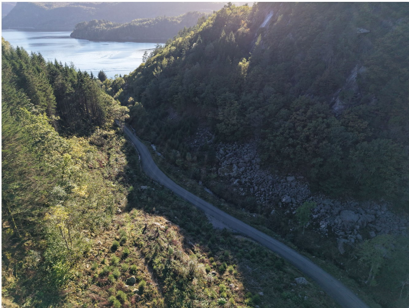
Tosåsbekken mellom veien og ura i bakgrunnen. – Foto: NMF (24.09.2026)
