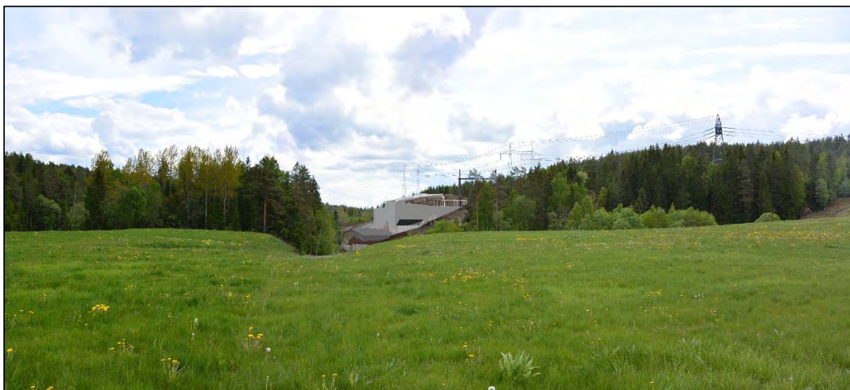
Figur 4-20. Visualisering av den nye transformatorstasjonen sett fra friområdet på Grønmo. Deler av det nye anlegget og nye master blir synlig sett herfra. Visualisering: E. Hjerkin, Multiconsult.
