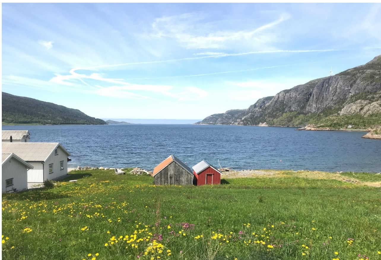
Figur 4.1. Landskapet i utredningsområdet er variert og veksler mellom dalbunn preget av flatt jordbrukslandskap i nærhet til sjøen og bakenforliggende fjell med skogklede bratte lisider. Her fra Hofstad der sjøkabel skal ilandføres og føres videre i jordkabel.
