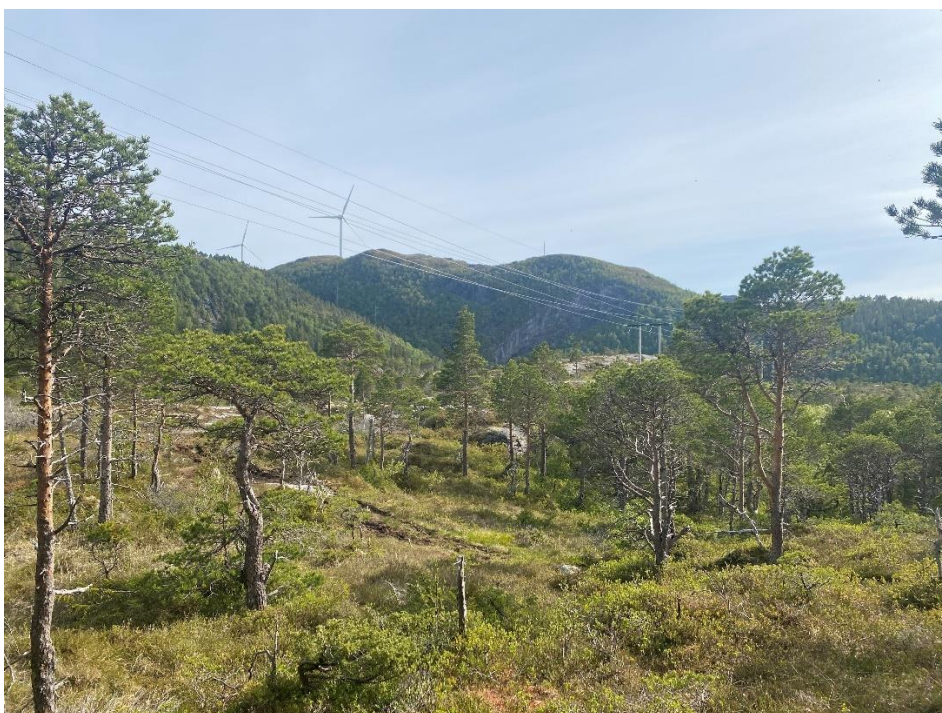
Figur 4.3. Vegetasjonen er stort sett grandominert med innslag av lauvskog, men furuskogen opptrer på mer eksponerte høydedrag med skinnere jordsmonn. Her fra Granmorantan nord for Straum transformatorstasjon med eksisterende 72 kV-kraftledninger og Roan vindpark i bakgrunnen.
