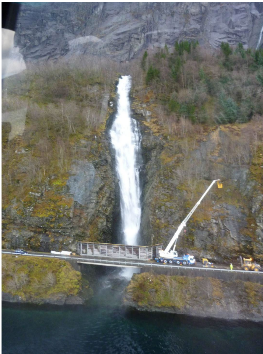
Figur 12: Fossen Hundsauna sett fra helikopter over fjorden (foto: Norconsult).
