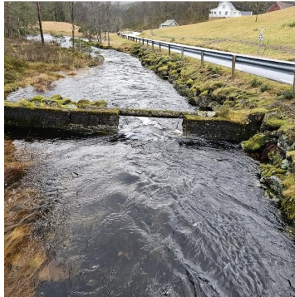
Figur 3 Vannstand under Høydalsbrua som referanse for Figur 1 og 2
