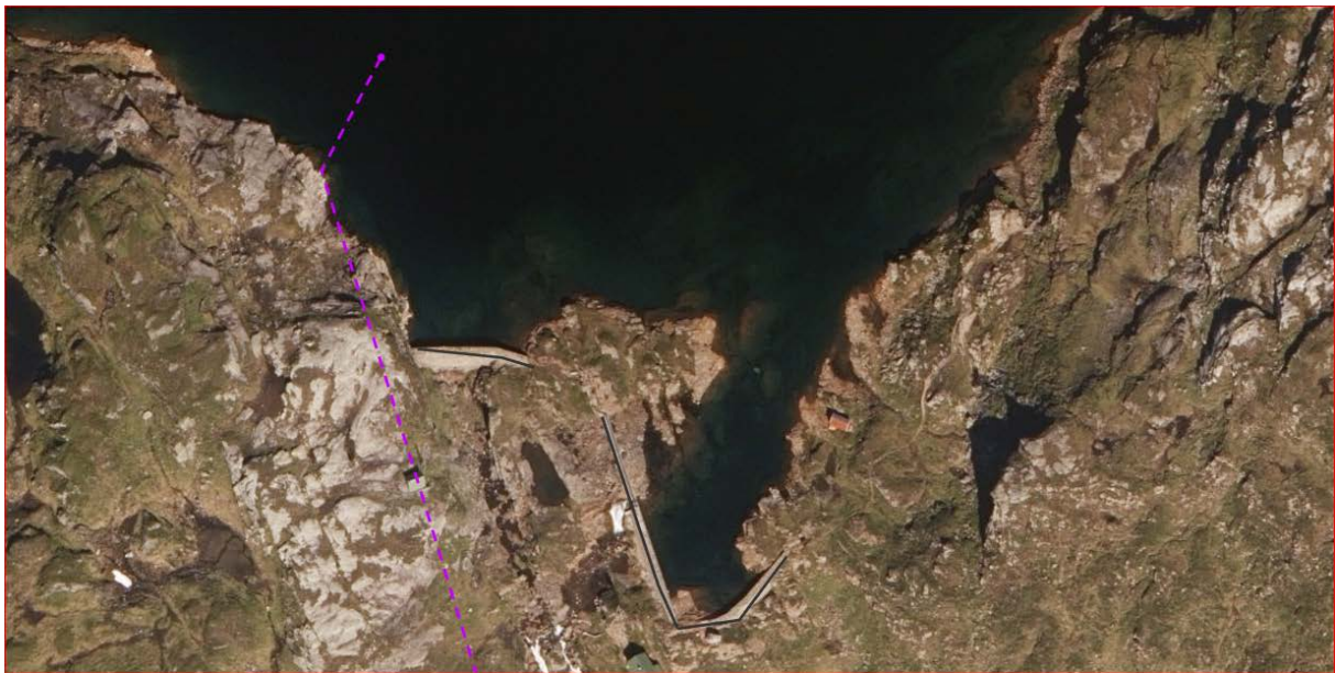
Figur 4 Nedste Dukavatnet vart regulert i 1938 då senkingstunnelen og dammane vart bygde. Den gang var berre Frøland kraftverk fra 1912 bygd i vassdraget. På flyfoto ligg lukehuset til venstre og Eviny sitt naust til høyre. Eviny si driftshytte kan skimtast nest i bildekanten
