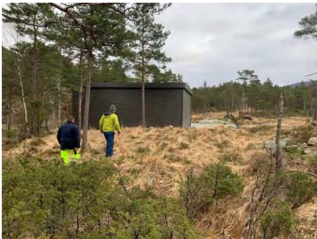
Bilde som viser vassverksinntaket, stasjonen blir stående til høyre
