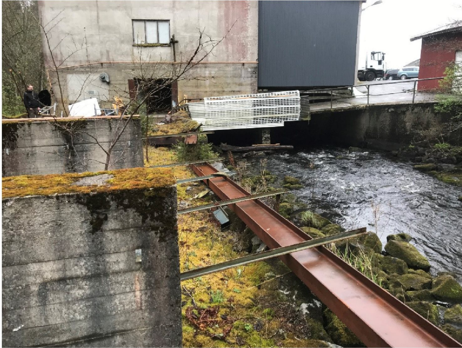
Bilde 9 Elvekulvert under industribygget (mølla).
