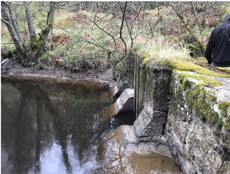
Bilde 7: Eksisterende dam er ca. 2,0-2,5m høy, sett fra inntaksmagasin med to luker.
