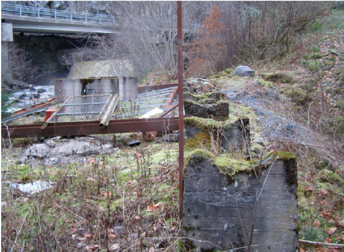
Bilde 6 viser rester etter rørfundamenter mellom inntaksdam og Brekke kraftverk, ny midlertidig vannvei vil bli forankret i tilknytning til eksisterende fundamenter, eventuelt fundamentert med gravitasjonslodd til høyre for de gamle fundamentene.
