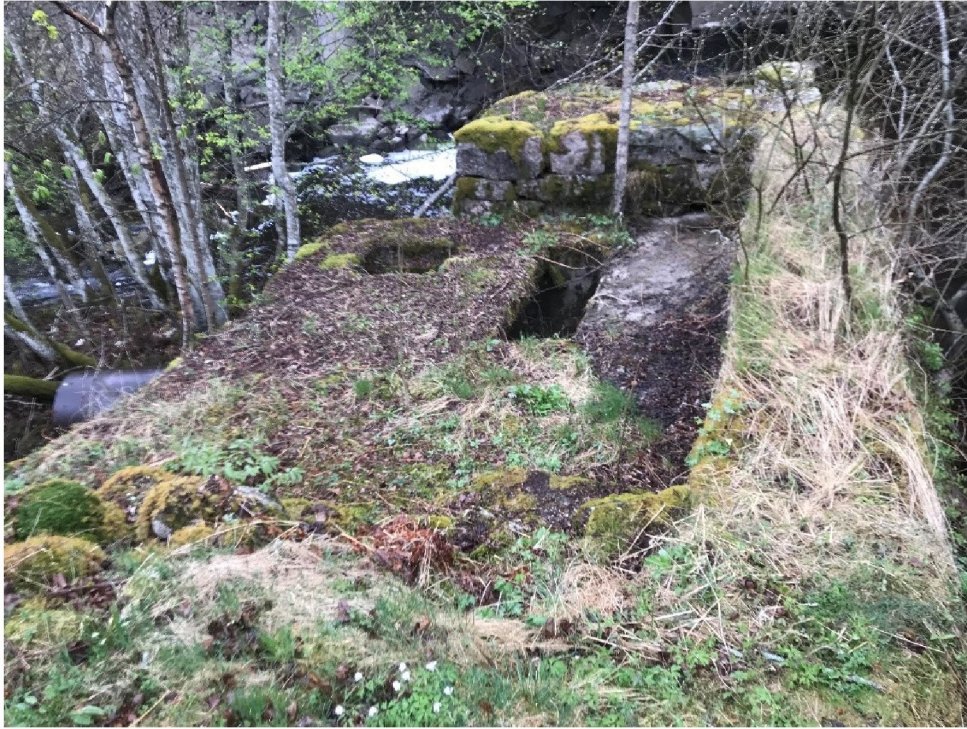
Bilde 8: Viser dam fra venstre vederlag med deler inntak med inntaksrør ved Brekke Mølle.
