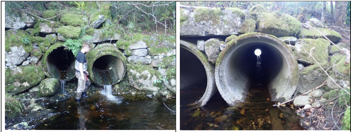
Figur 50. Rørene som går under Suldalsvegen er vannføringsavhengig vandringshinder for oppvandrende laks og aure.
