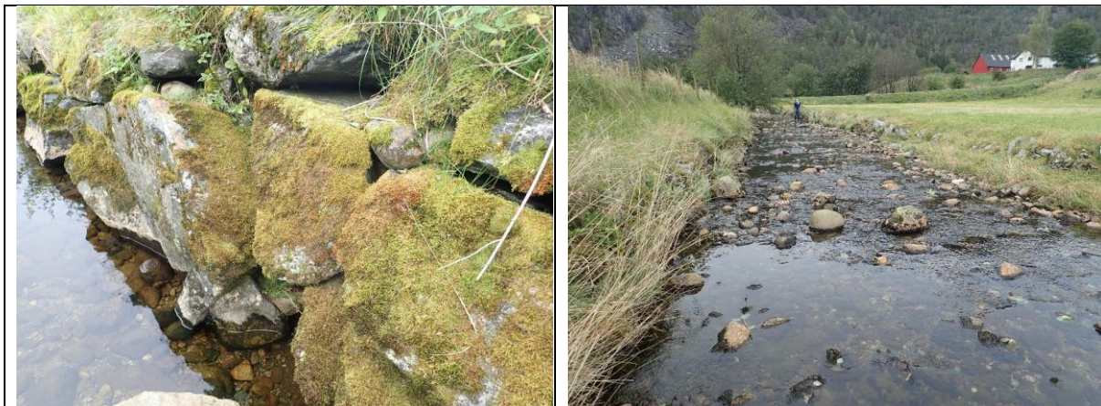
Figur 117. Eksempler på inngrep i Kvæstadbekken. Erosjonssikring (venstre) og fjernet kantvegetasjon langs breddene (høyre).
