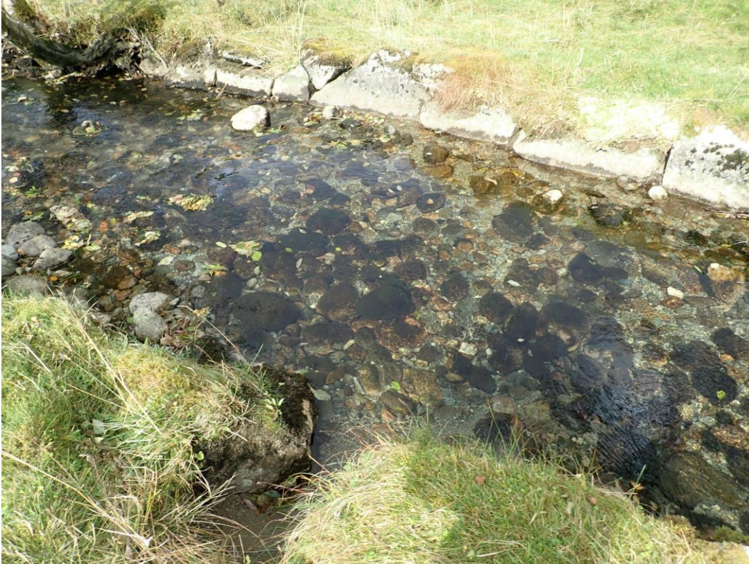
Figur 125. Erosjonssikring i midtre delen av Strapajuvet
