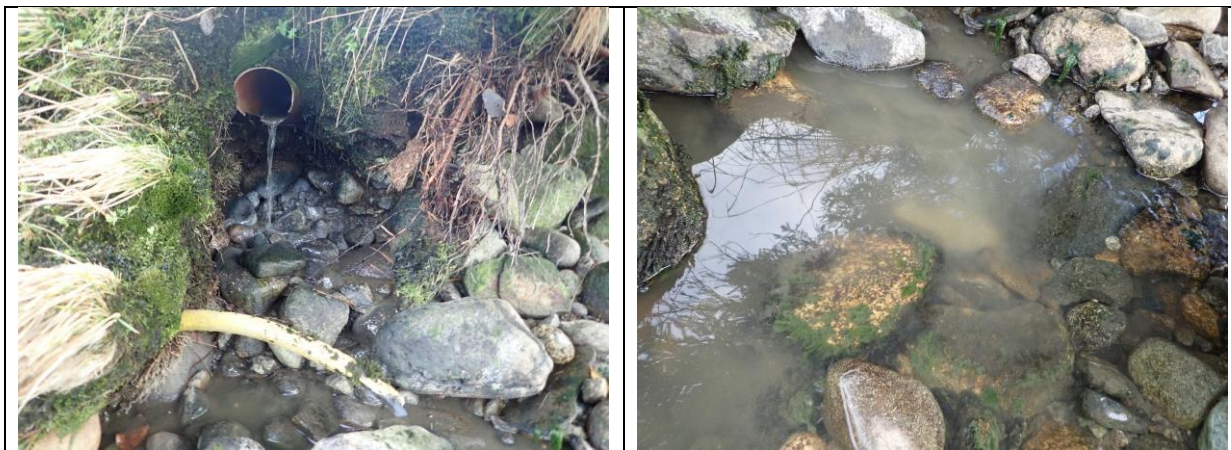
Figur 55. Utslipp fra et rør i Mosåna like oppstrøms for samløpet med Kvepsabekken. Vannet som kom ut luktet sterkt av kloakk.
