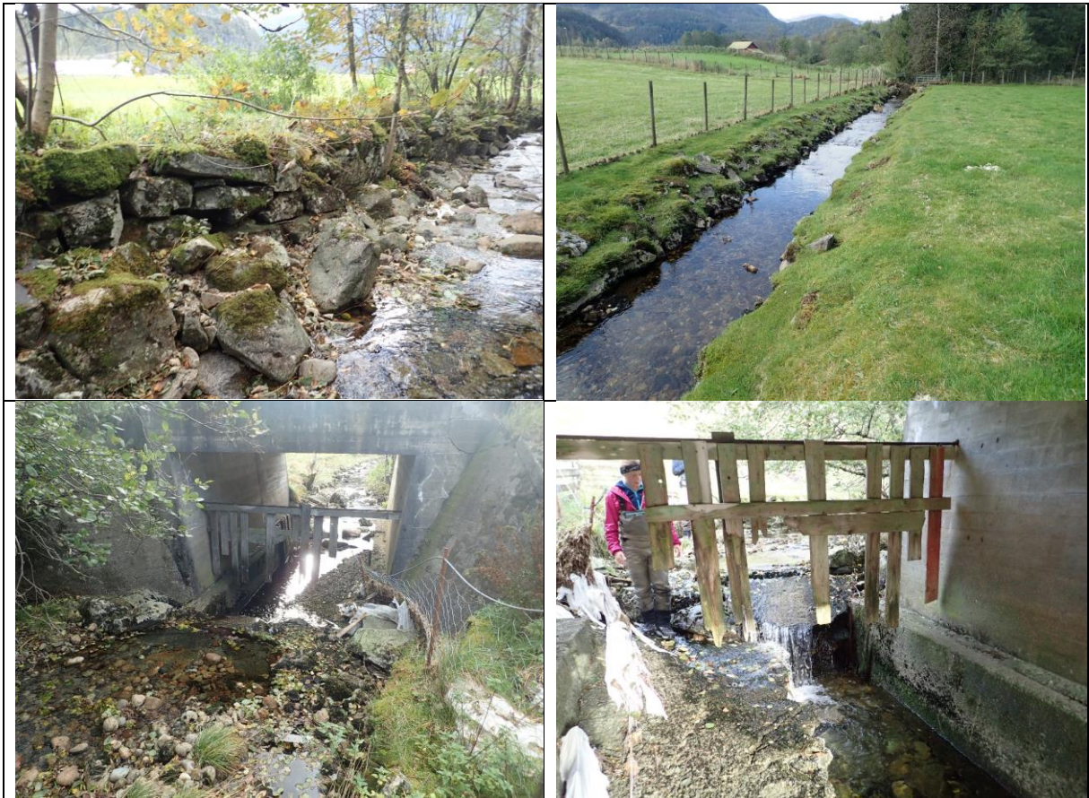
Figur 95. Eksempelbilder av inngrep og påvirkninger i Lundebekken. Øverst: Erosjonssikret elvebredde (venstre) og kanalisert strekning med fjernet kantvegetasjon på begge elvebredder (høyre). Nederst: Unaturlig fossefall ved kulverten under veibroen helt nederst i Lundebekken sett nedstrøms (venstre) og oppstrøms (høyre).
