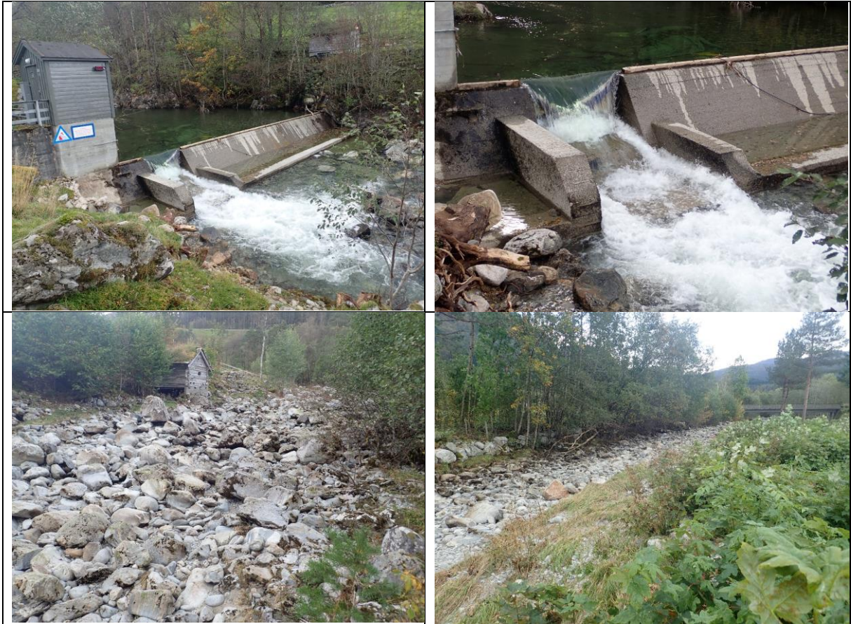
Figur 110. Eksempelbilder av inngrep og påvirkninger i Kvilldalsåa. Øverst: Demning (venstre) og spalteåpningen av selve demningen (høyre). Nederst: Tørrlagt sideløp i øvre (venstre) og nedre delen (høyre) av Kvilldalsåa.
