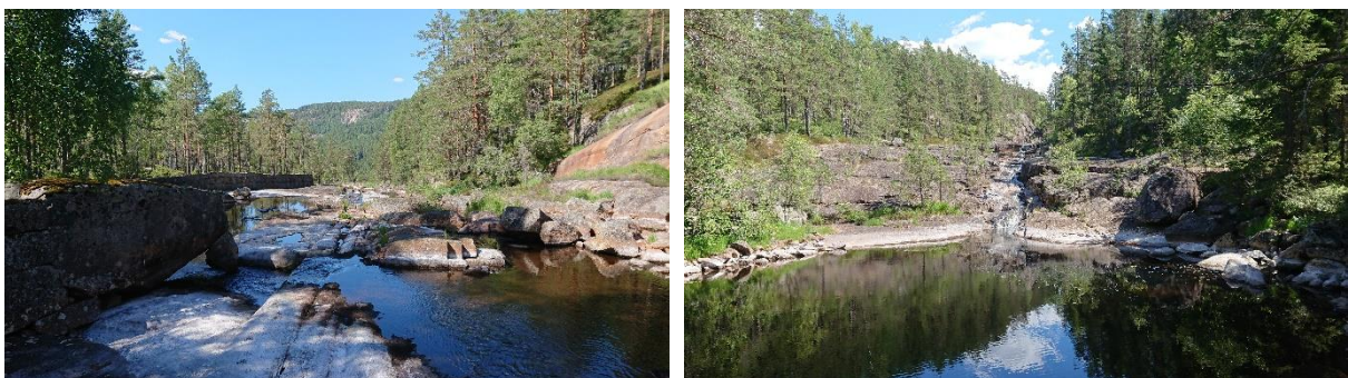
Figur 9: Til venstre parti av Husåna med elveforbygning langs midtre parti av strekningen som vil få fraført vann. Til høyre sees stor kulp i bunnen av Husåna, samt mindre fossefall i nedre del av «Kloveb». Foto: Faun Naturforvaltning.
