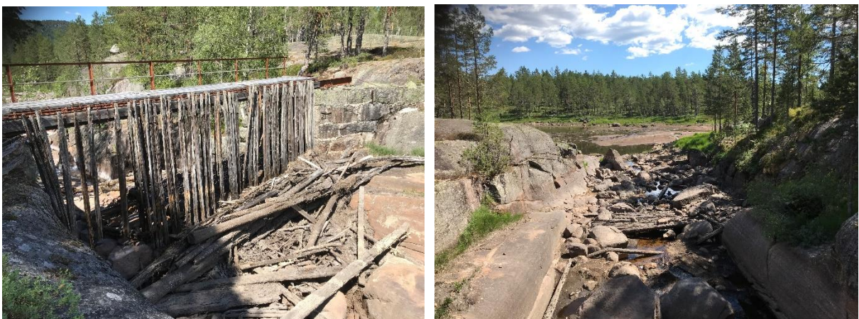
Figur 3: Bildene over viser eldre dam, samt del av Husåhylen planlagt brukt som inntaksbasseng for Husåna kraftverk. Foto: Rolf Svan Amundsen.
