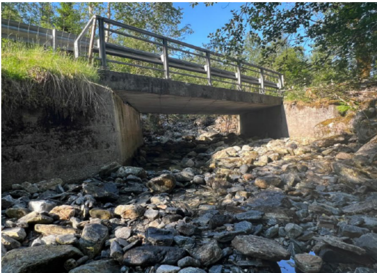
Figur 25: Dagens bro ved Almelibotn som rives. Bildet er tatt oppstrøms elven.
