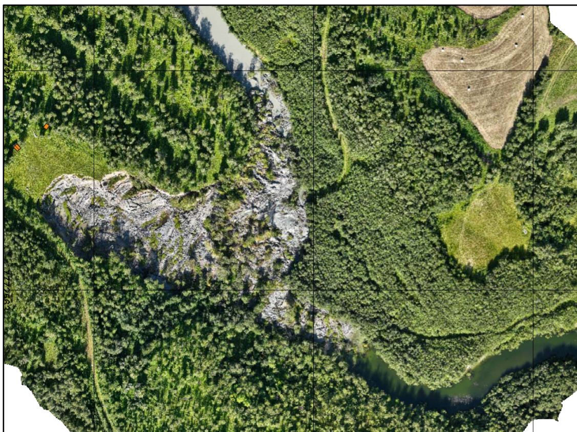
Figur 4: Ortofoto av Brennelva og skredmassene fra 8.8.2024. Figur fra NVEs tiltaksplan.
