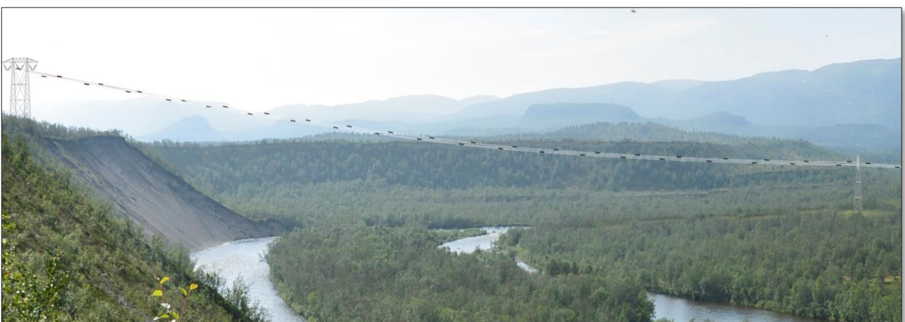
Figur 5-2: Utsnitt av eksempel på kryssing av Stabbursdalen med tre duplex faseliner med diameter 2 x 3,8 cm og armeringsspiraler malt med svart kontrastfarge. På nært hold vil den svarte kontrastfargen være synlig mot horisonten.
