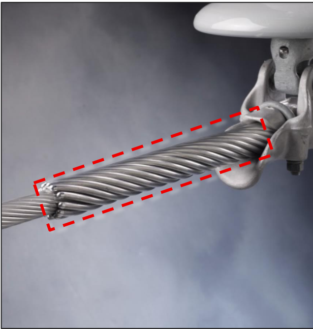
Figur 2-1: Armeringsspiral.
