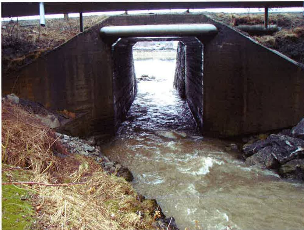
Ved utløpet til Stjørdalselva er det erosjonssikret og bekken graver ikke noe her.
