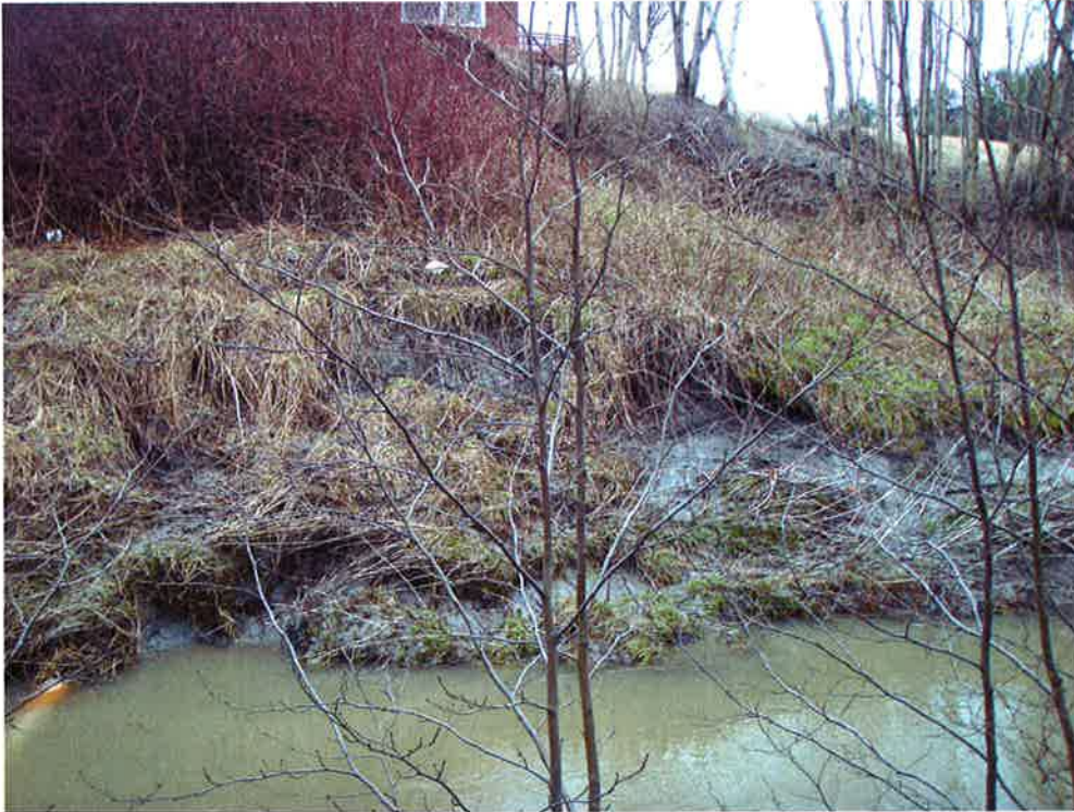
Erosjon nedenfor bolig på Hell.
